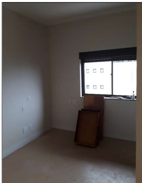
FOTO 22. Vista geral do dormitório.
