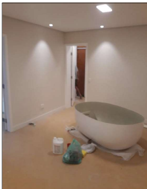
FOTO 21. Vista geral do banheiro social.
