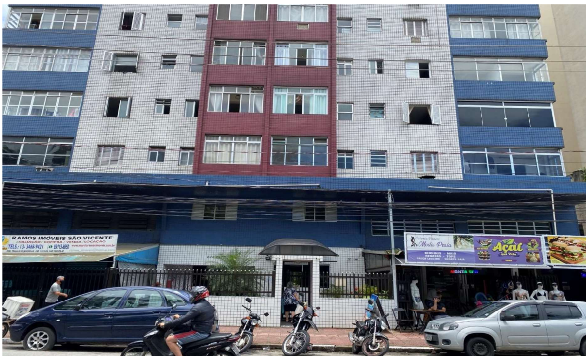
FOTO 03 – Detalhe da entrada do “Condomínio Edifício Itamarati” e lojas no térreo.
