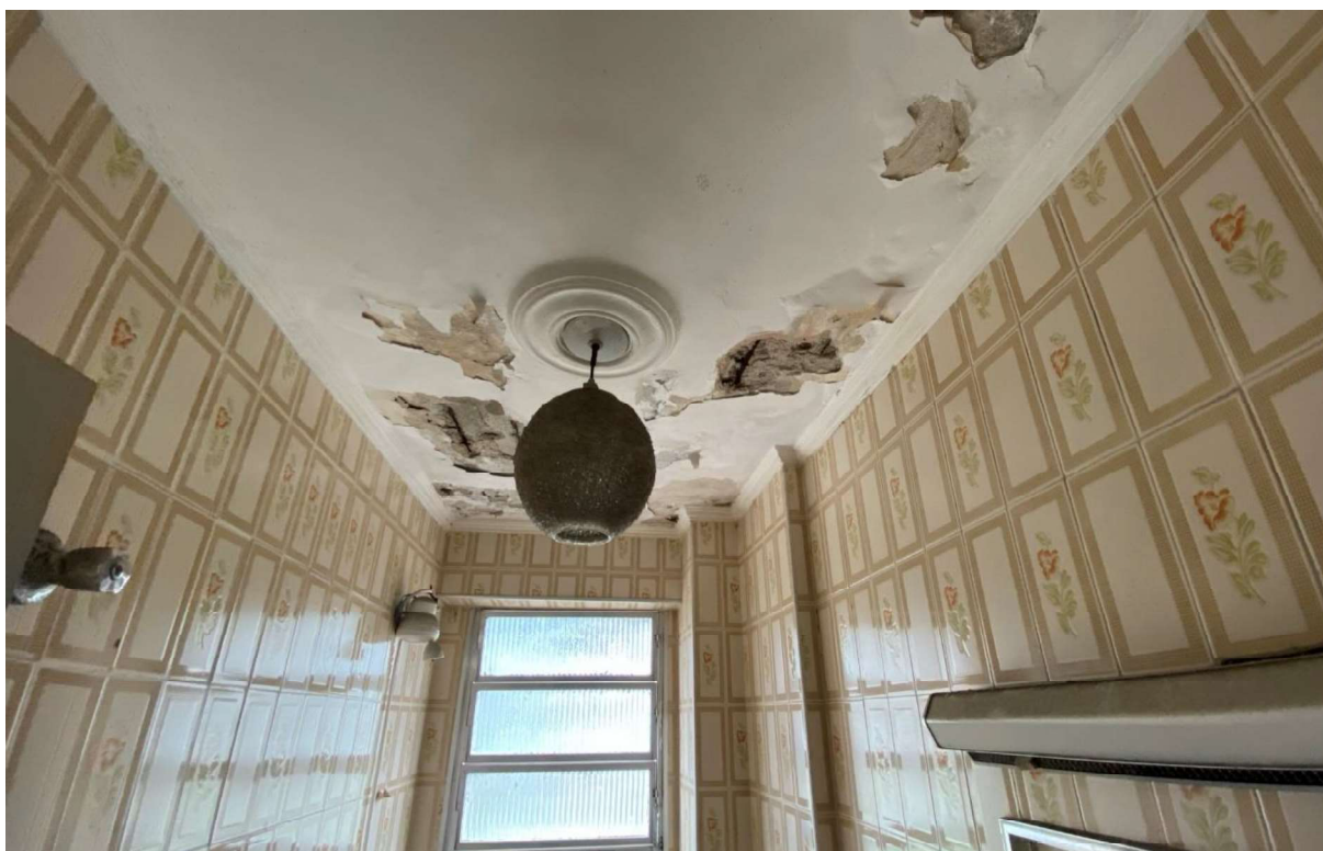
FOTO 11 – Vista parcial interna do estado do imóvel avaliando (Banheiro Social).
