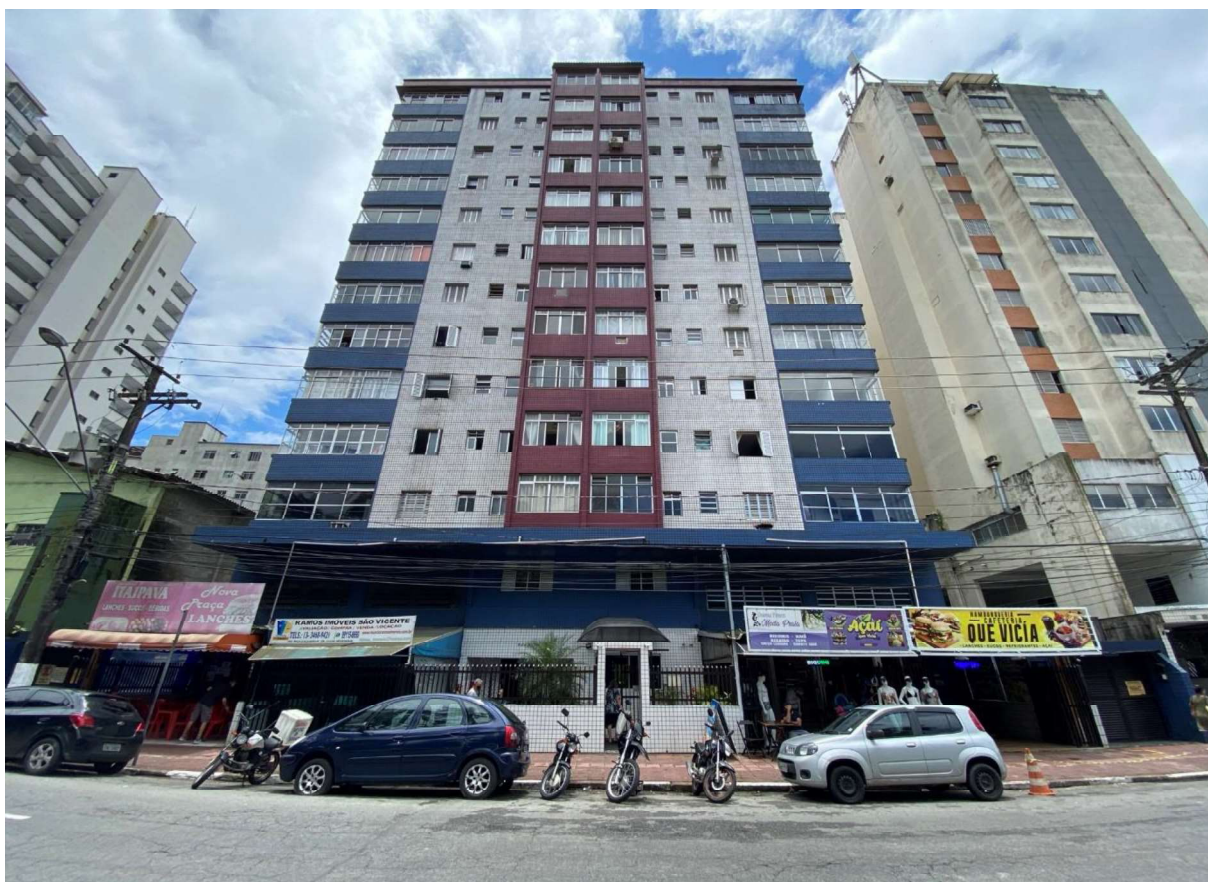
FOTO 02 -Vista parcial da fachada frontal do “Condomínio Edifício Itamarati” (Fachada).
