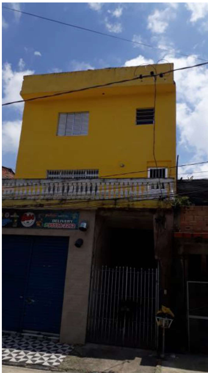
Foto 01 – Vista frontal do imóvel avaliando.
