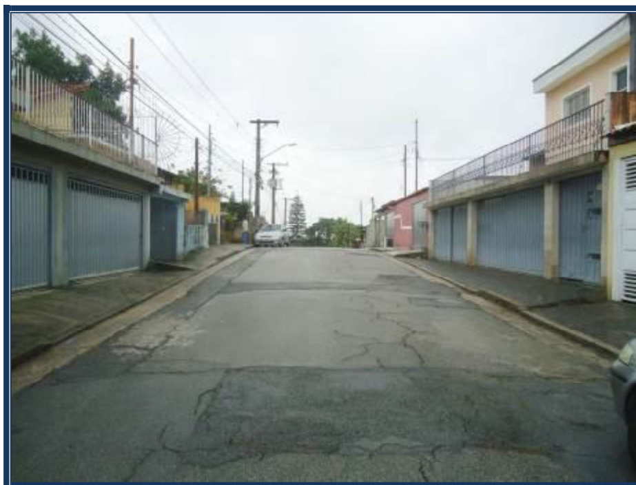
Vista da Rua Pimentel Brandão que lhe dá acesso.
