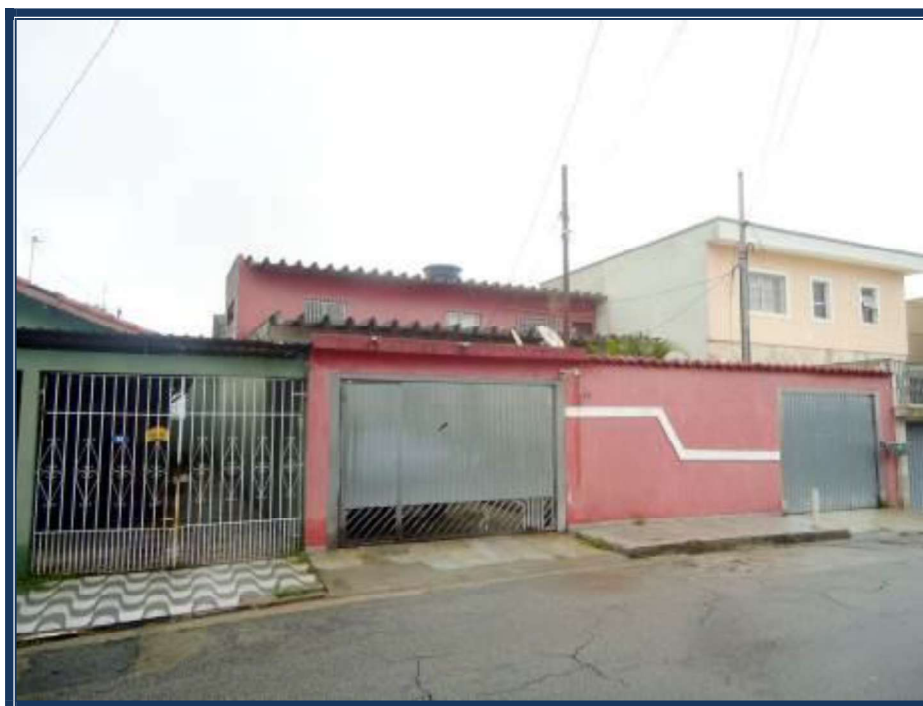
Vista da frente do imóvel avaliando.
