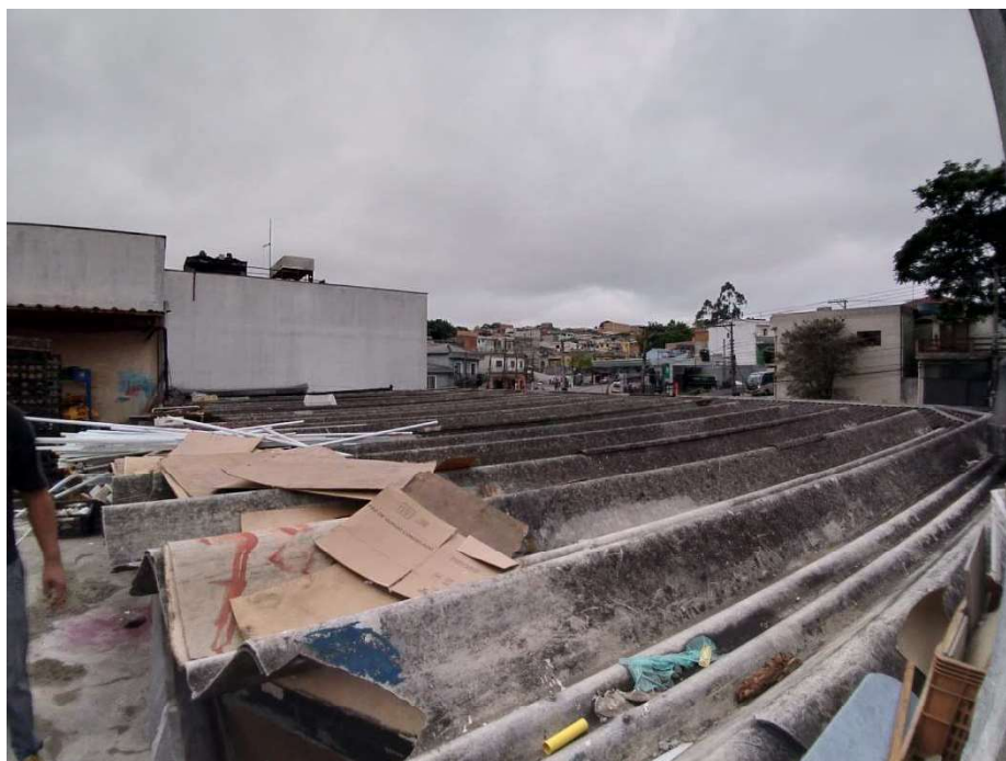
VISTA DA COBERTURA CONSTRUÍDA NO IMÓVEL OBJETO DA PRESENTE AÇÃO.
