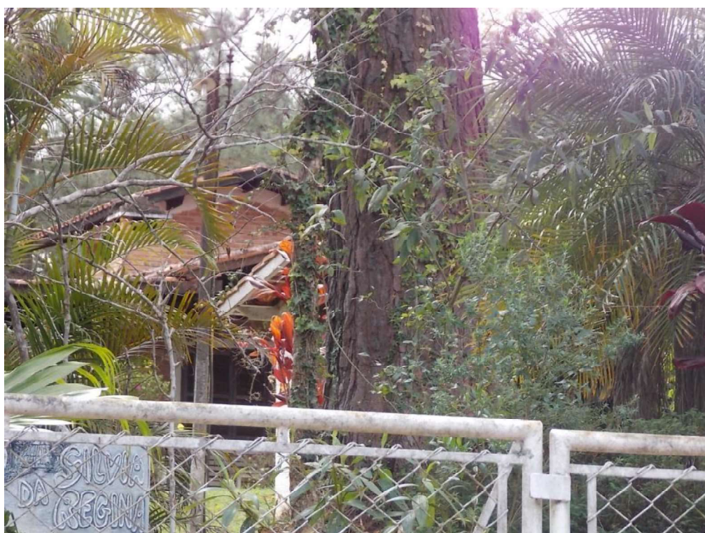
Vistas da construção principal.
