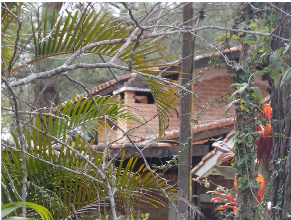
Vistas da construção principal.
