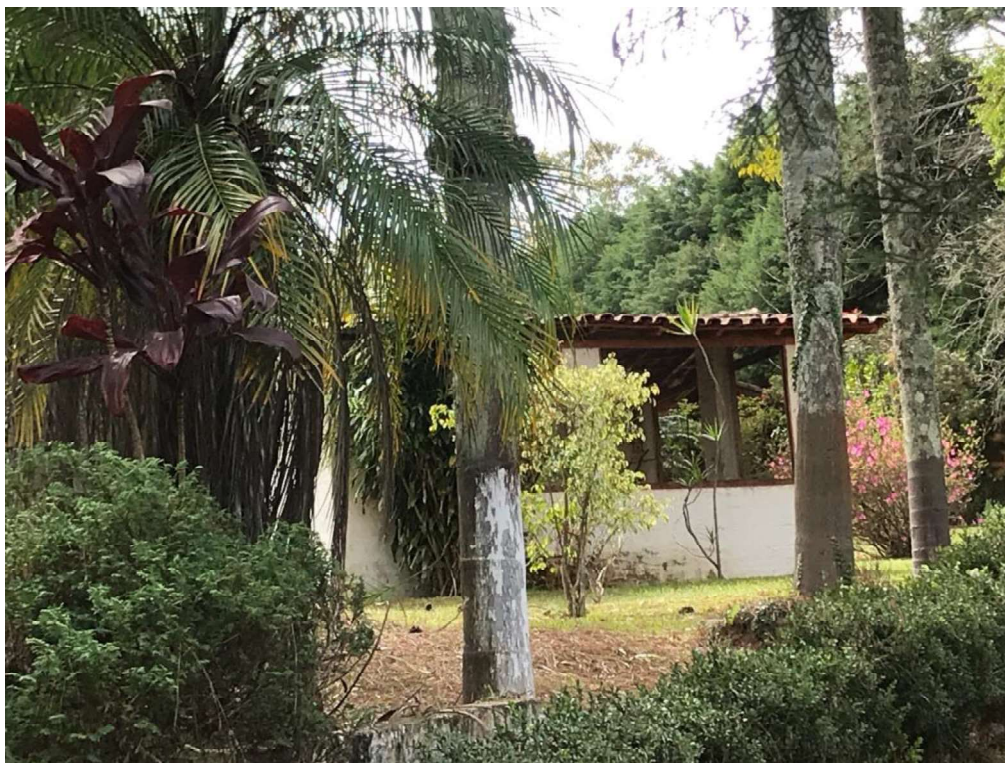
Vistas da construção principal.
