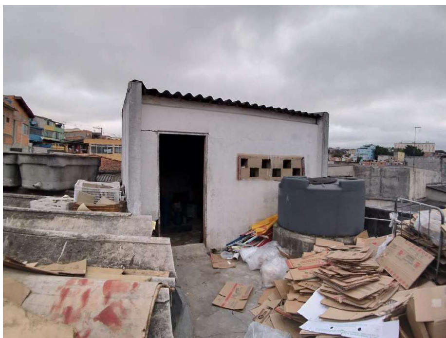
VISTA DO DEPÓSITO DE MATERIAIS.
