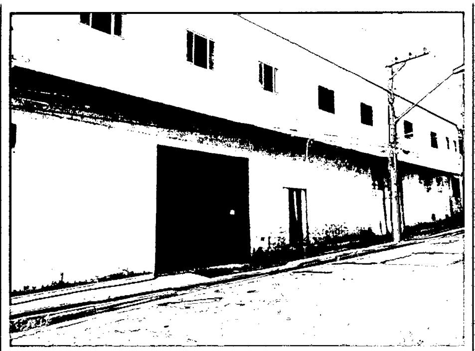
FOTO 02 – Detalhe das entradas e dos vãos no piso superior sem esquadrias
