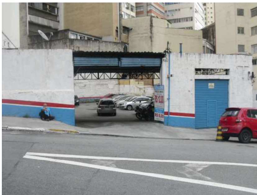
Foto 15 – Frente do imóvel avaliando - Rua Asdrúbal do Nascimento nº 230
