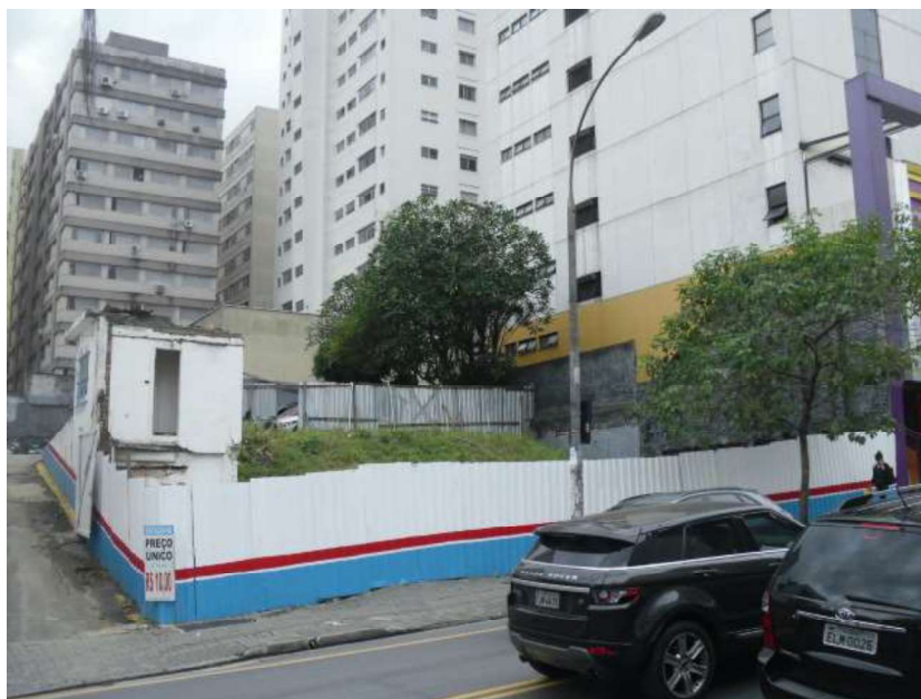
Foto 01 – Frente do imóvel avaliando, Rua Augusta nº 2.204
