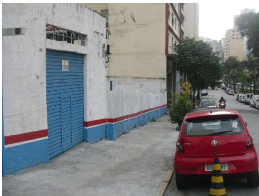
Foto 16 – Frente do imóvel avaliando
