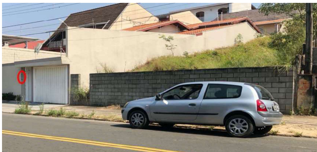
Imagem 02: Imóvel nº 435 da Rua das Vitórias Régias, vizinho ao Lote 17 da Quadra C
