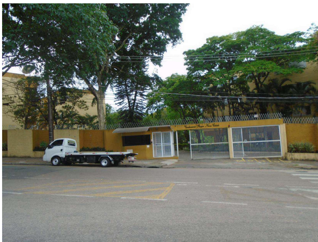
Figura 4. Entrada do condomínio
