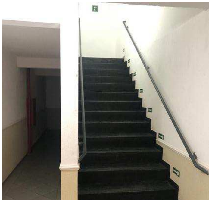
Imagem 12: Escadas de acesso a pisos superiores
