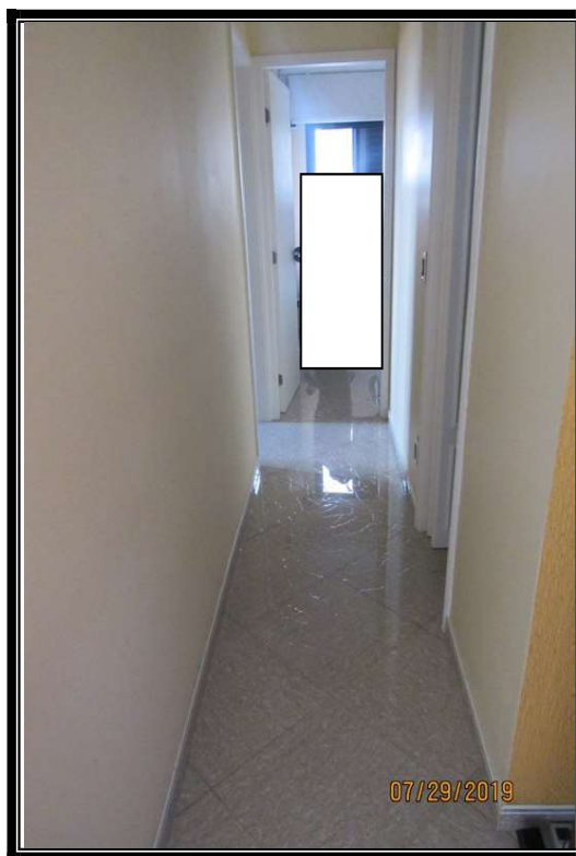
CORREDOR DE ACESSO AOS DORMITÓRIOS E BANHEIRO
