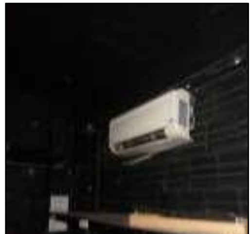
ITEM 14,014 - AR CONDICIONADO
