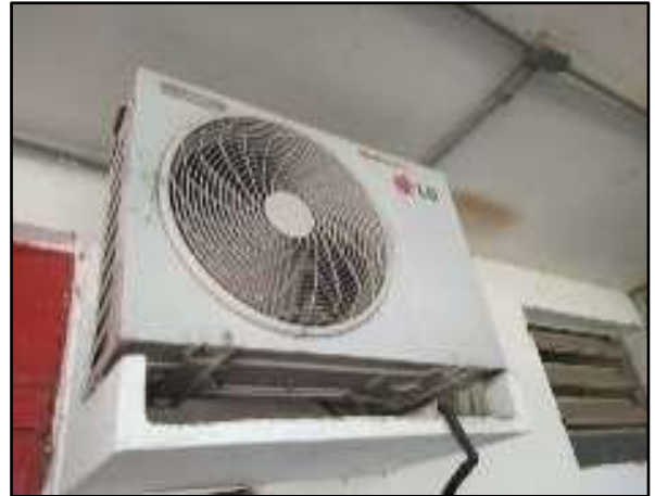
ITEM 11,016 - CONDICIONADOR DE AR TIPO AIR SPLIT E SUA UNIDADE CONDENSADORA
