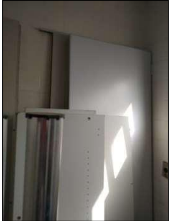
ITEM 11,117 - DIVISÓRIAS DE MADEIRA
