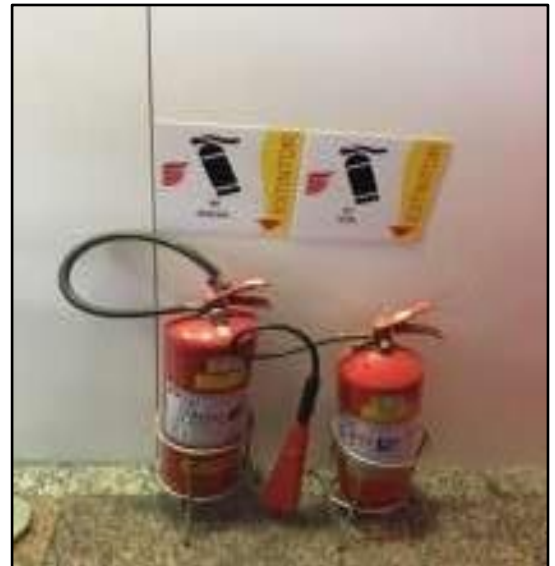
ITEM 14,052 E 14,053 - EXTINTOR DE INCÊNDIO TIPO A E EXTINTOR DE INCÊNDIO TIPO B C
