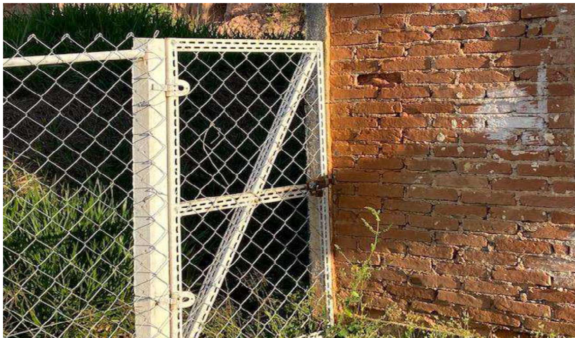
Foto 22 – Entrada para a área edificada (Entrada 1)
