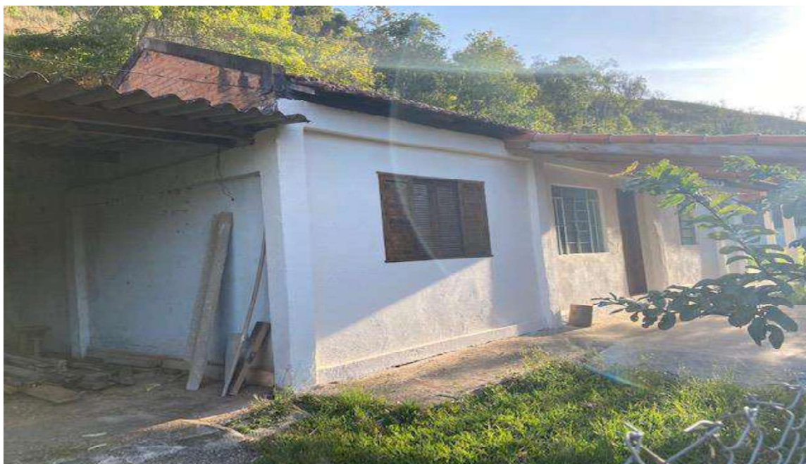
Foto 2 – Construção com estado de conservação regular
