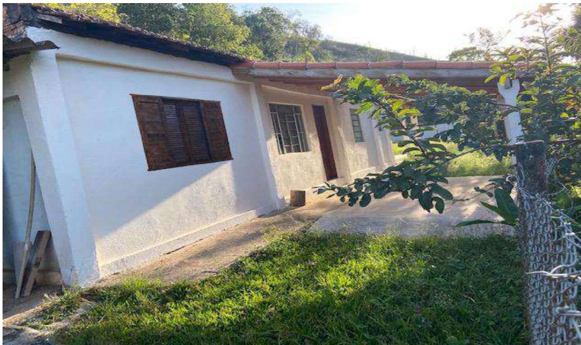
Foto 20 – Fachada da área edificada com estado de conservação regular
