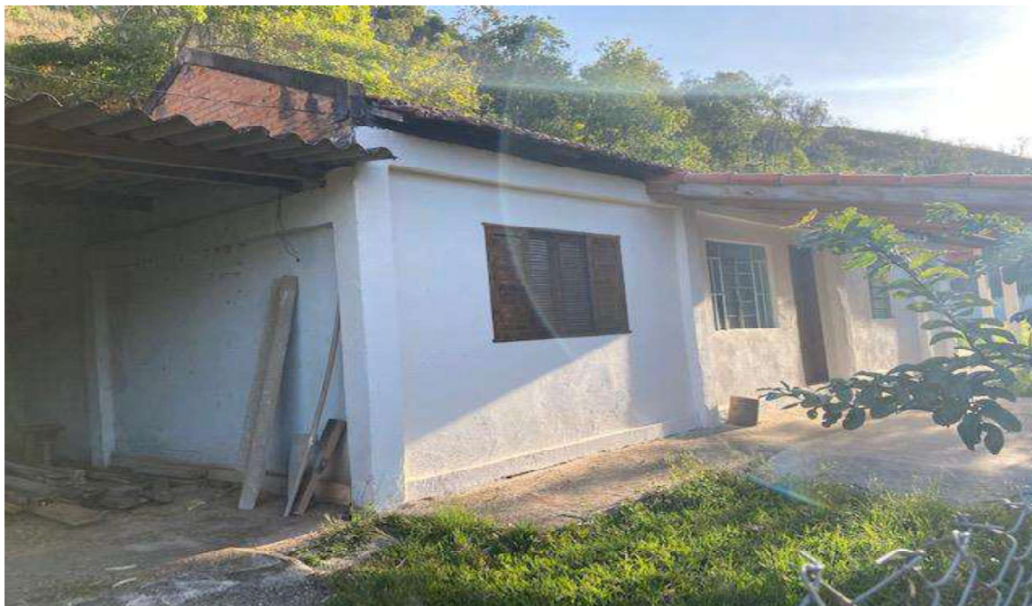
Foto 18 – Vista da área edificada com estado de conservação regular
