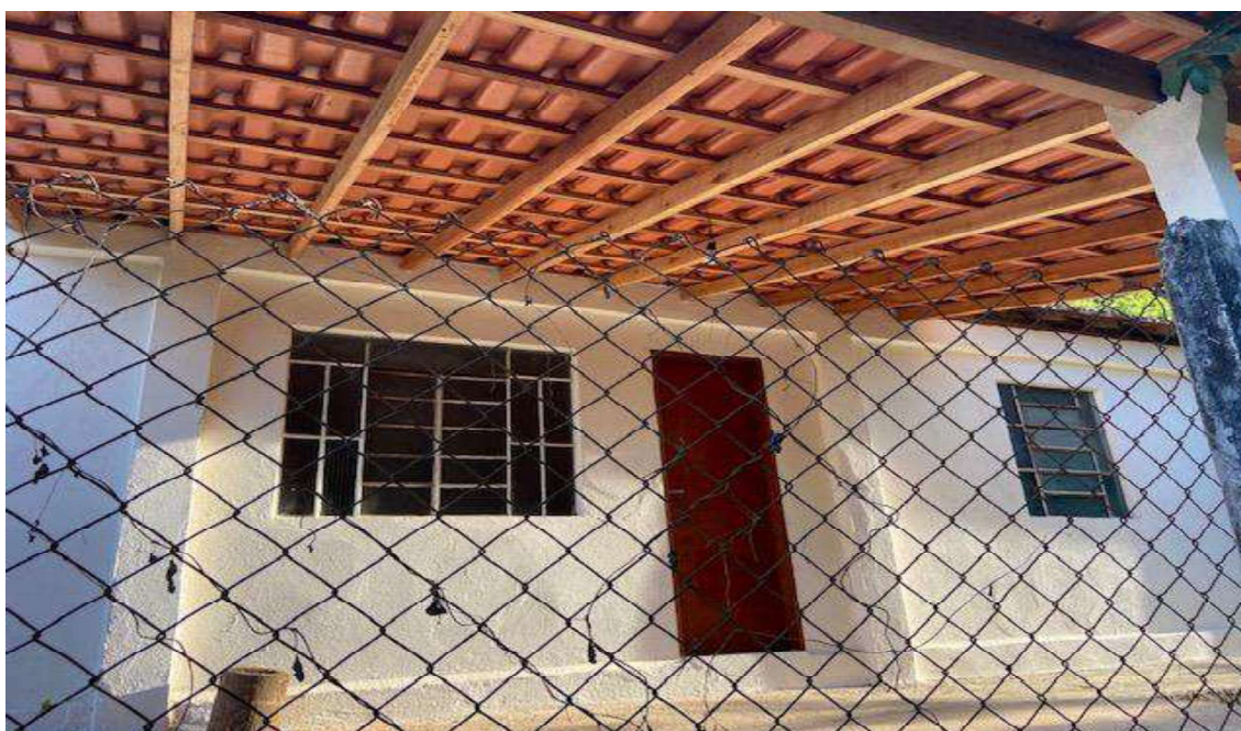
Foto 19 – Fachada da área edificada com estado de conservação regular
