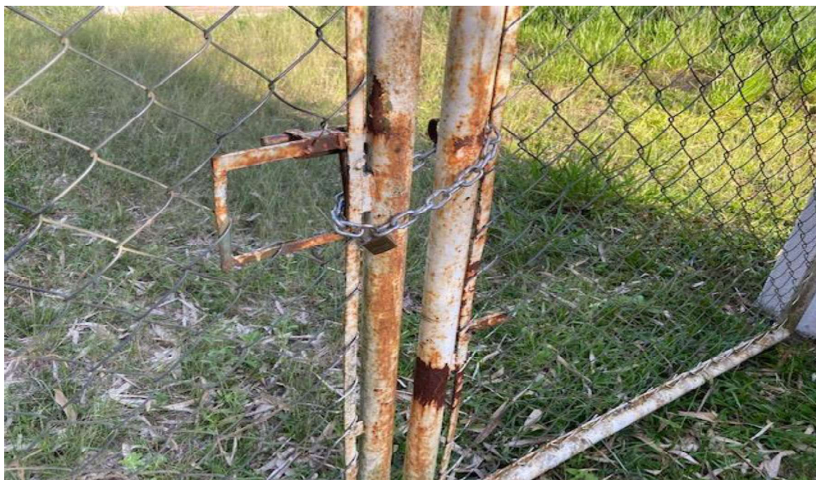
Foto 23 – Entrada para a área edificada (Entrada 2)
