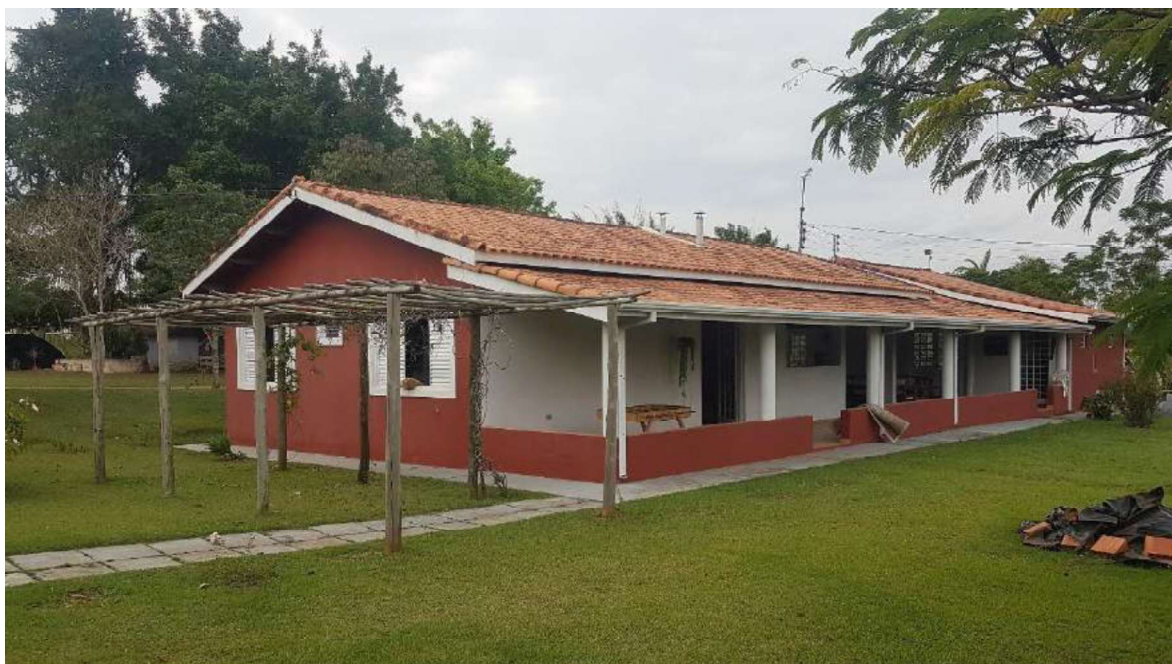
Foto 58 – Vista geral da gleba “C”, casa sede
