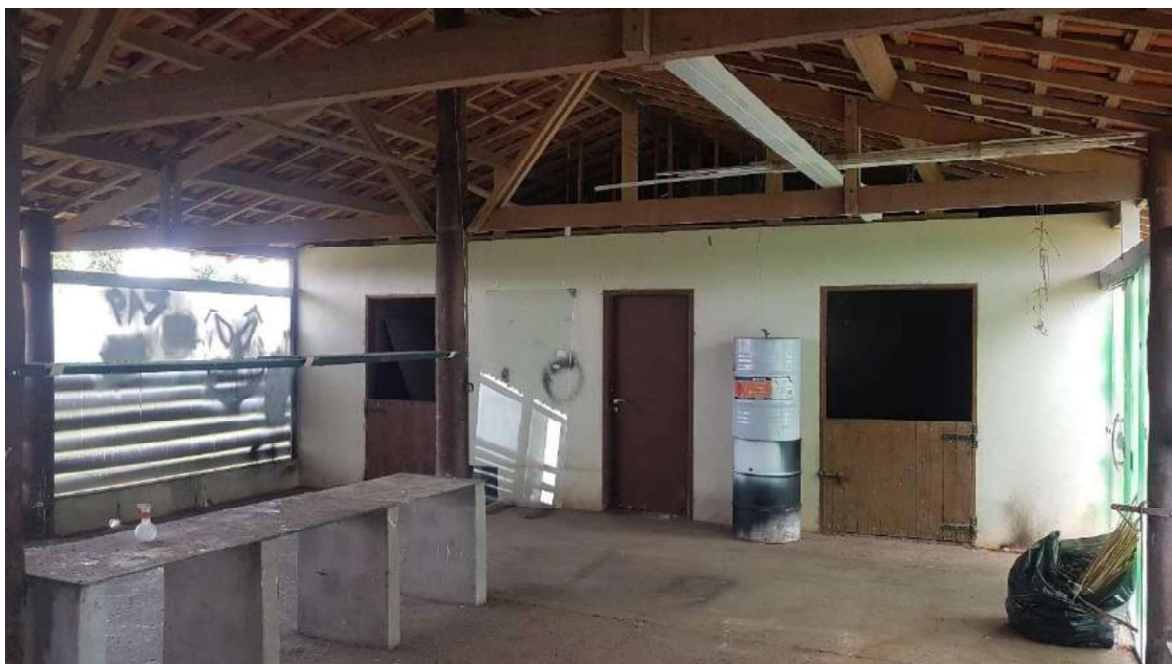
Foto 49 – Vista geral da gleba “C”, oficina de vidros
