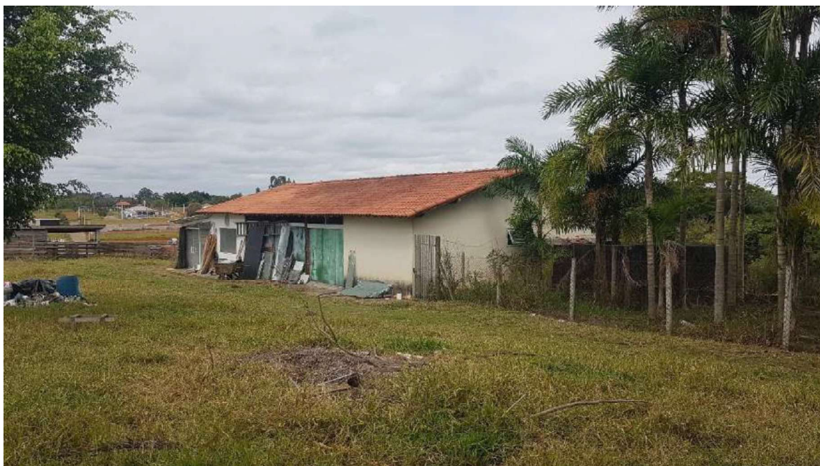
Foto 53 – Vista geral da gleba “C”, oficina de vidros
