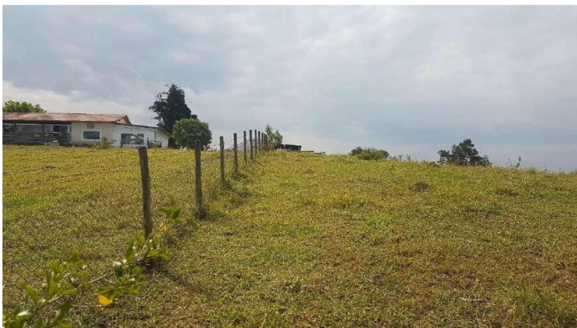
Foto 25 – Vista geral da gleba “C”
