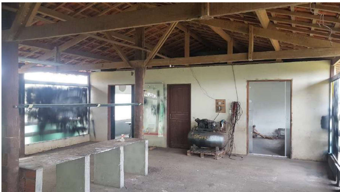
Foto 50 – Vista geral da gleba “C”, oficina de vidros
