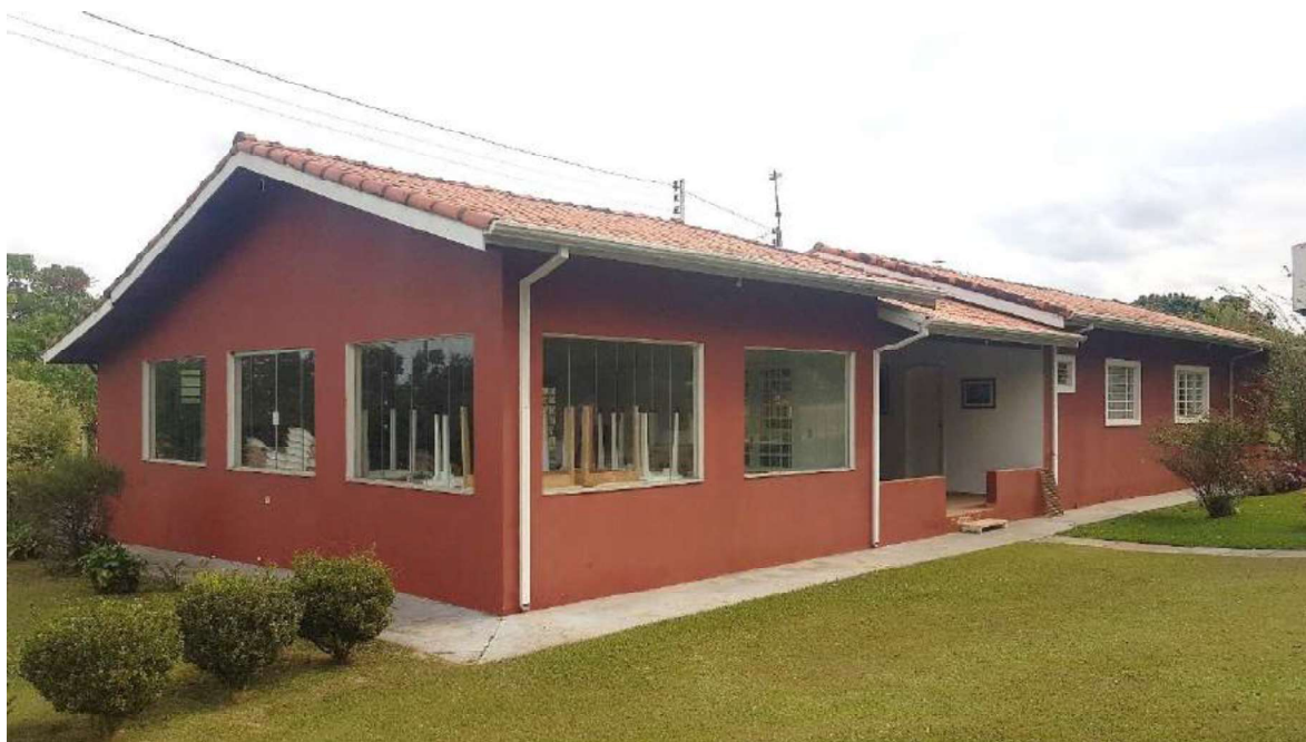
Foto 71 – Vista geral da gleba “C”, casa sede
