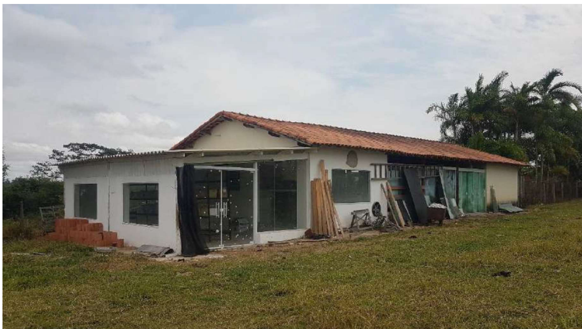
Foto 47 – Vista geral da gleba “C”, oficina de vidros
