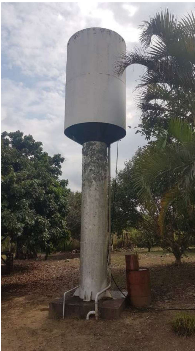
Foto 72 – Vista geral da gleba “C”, caixa d’água
