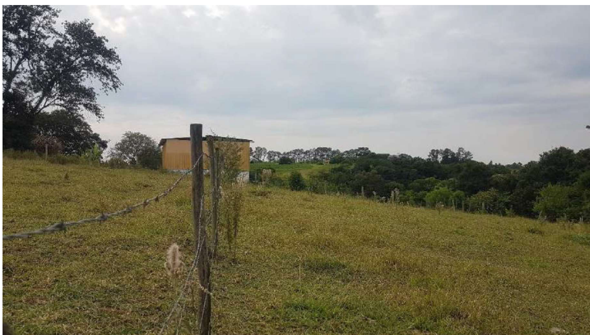
Foto 19 – Vista geral da gleba “C”
