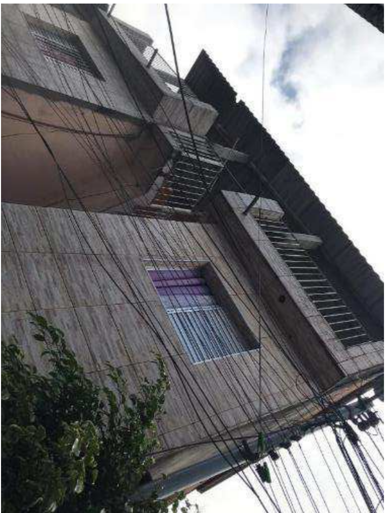
Foto 5: Vista da fachada da edificação.
