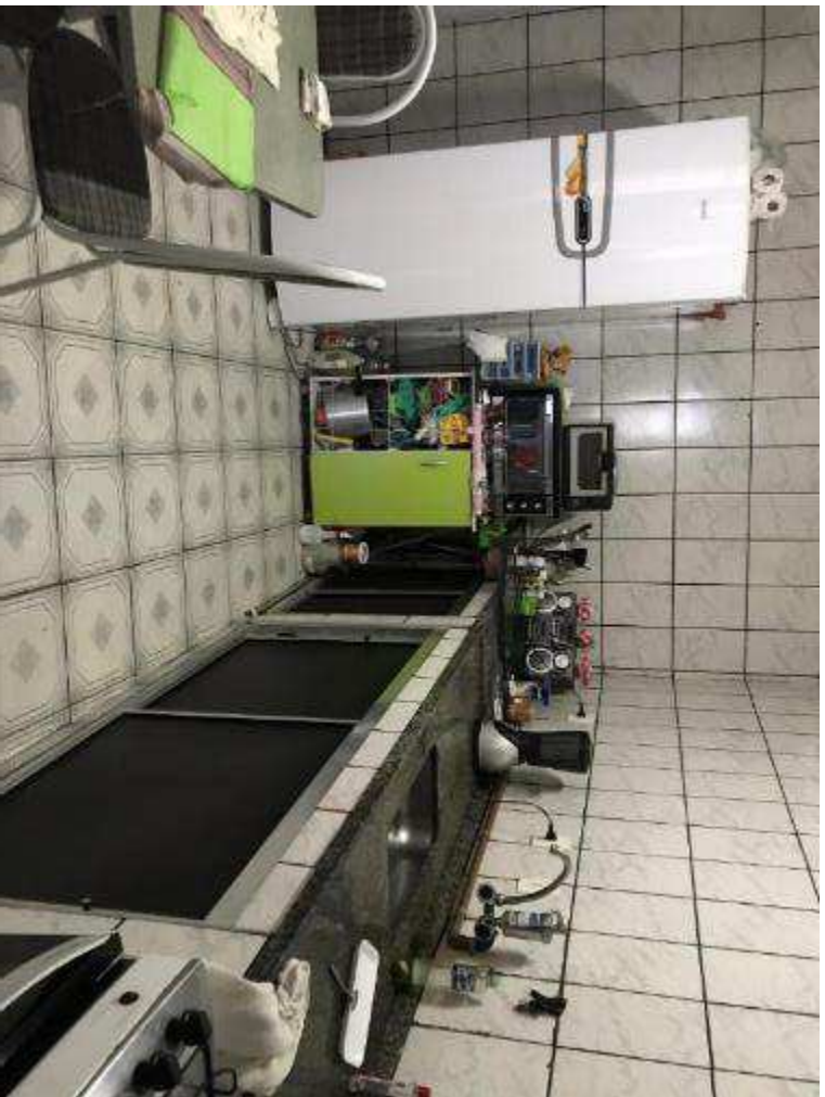
Foto 3: Vista geral da cozinha – unidade térrea.
