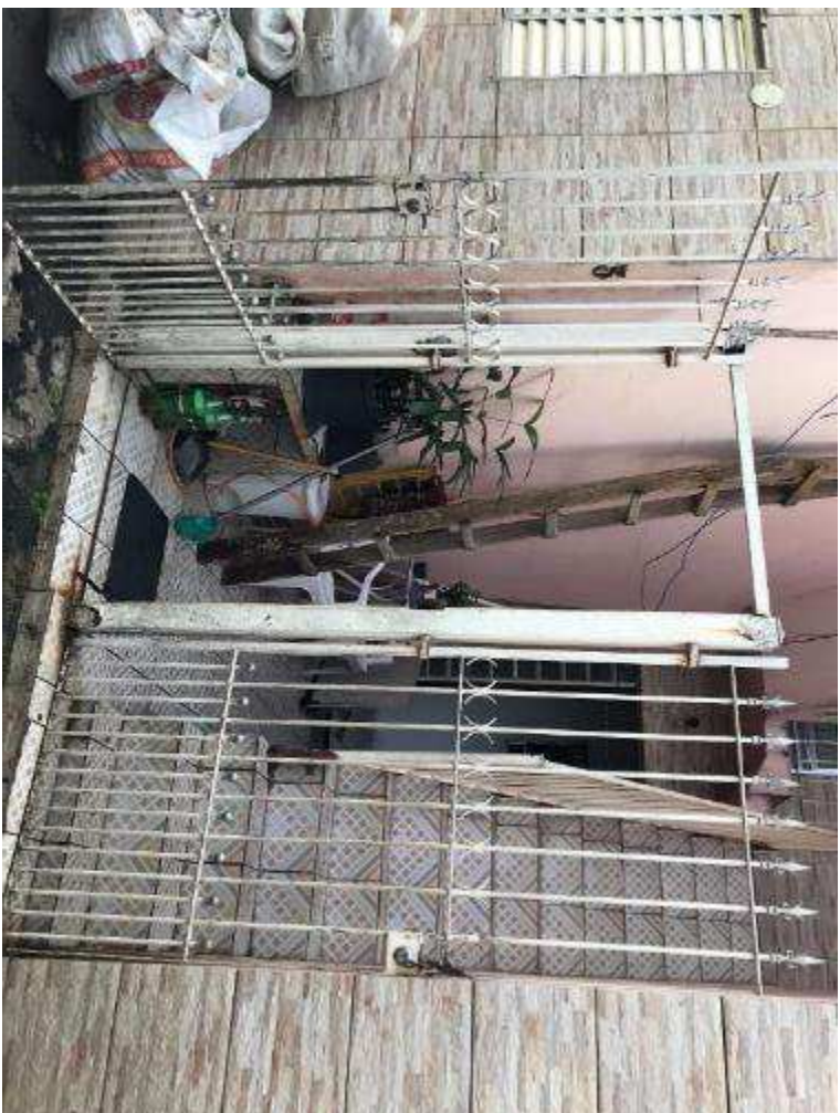
Foto 7: Vista do acesso à edificação – pavimento térreo e escada de acesso aos pavimentos superior e terraço.
