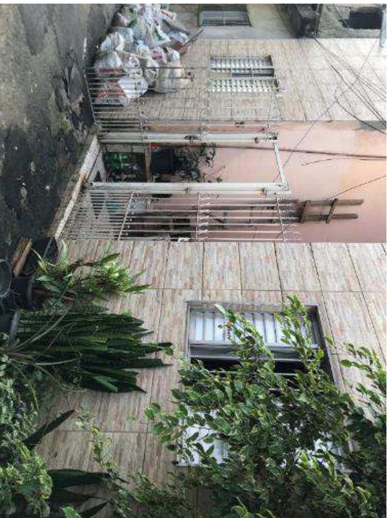
Foto 6: Vista da fachada da edificação - térreo.
