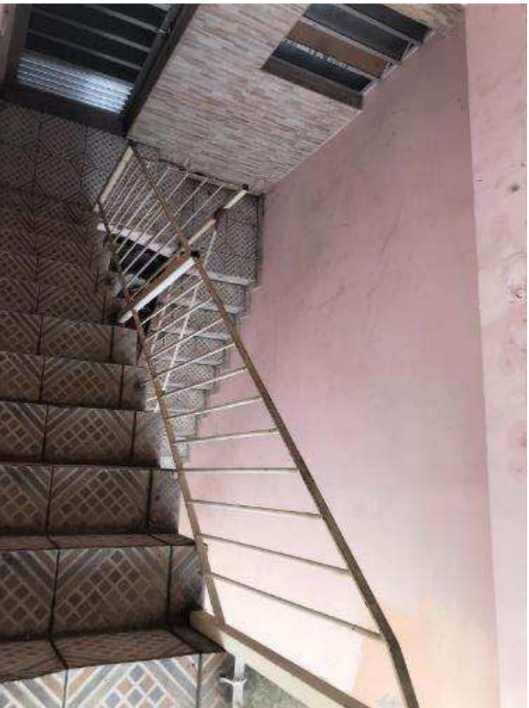
Foto 12: Vista geral da escada de circulação.
