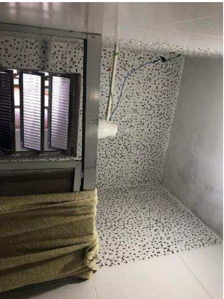
Foto 6: Vista geral do banheiro.
