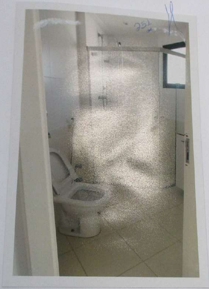
VISTA DO BANHEIRO II - SUÍTE.
