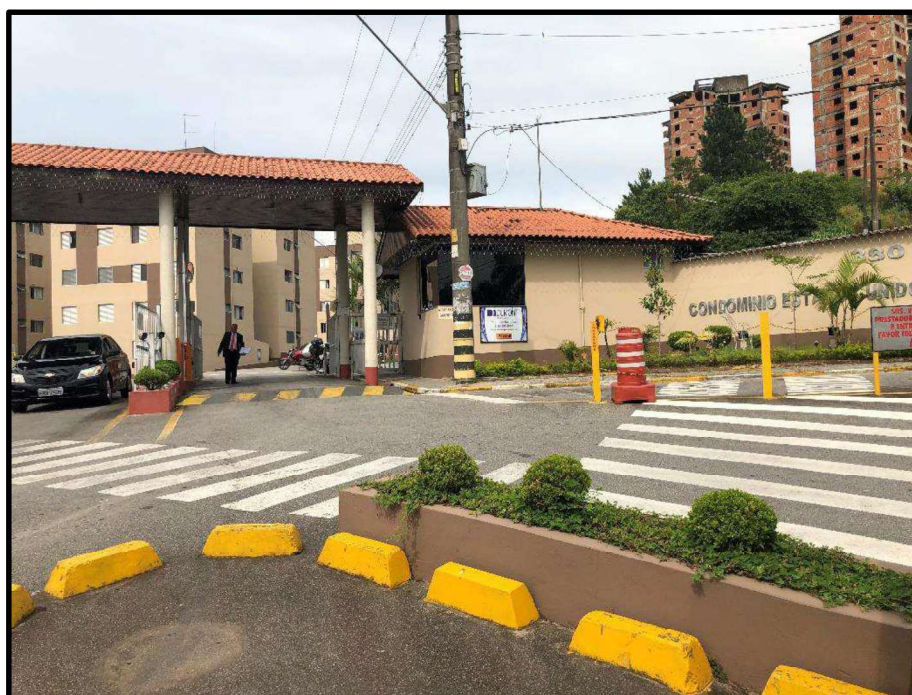
Foto 2 – Entrada do “Condomínio Estados Unidos”
