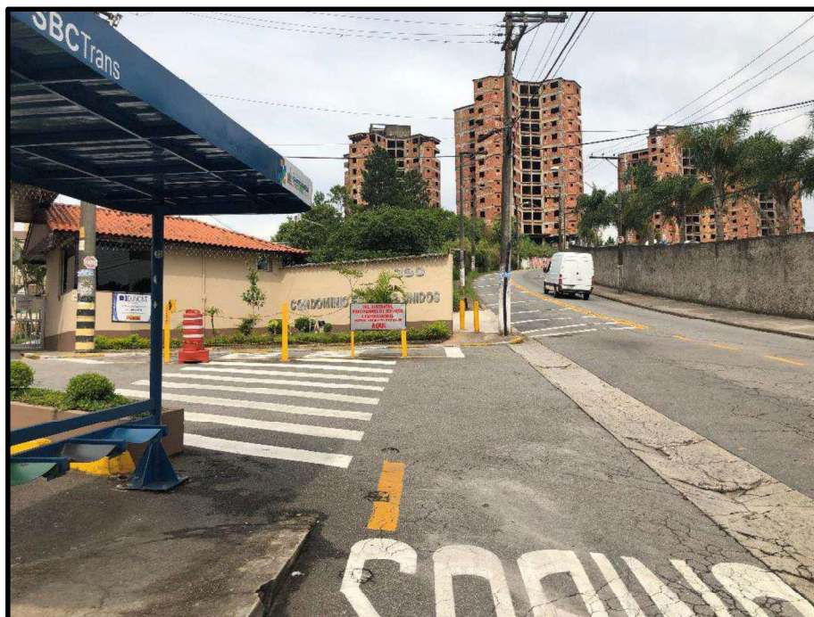
Foto 1 – Vista geral do acesso – Rua Gregório de Fregel
