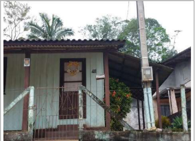
Frente (edificação existente)
