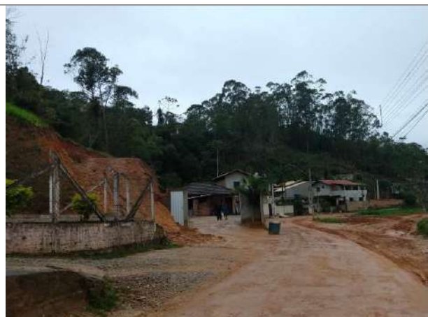
Frente (edificação existente)
