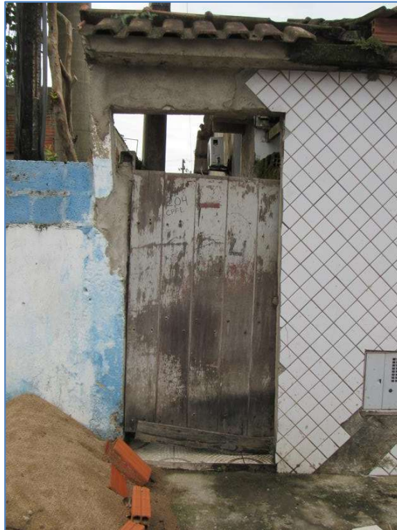
ASPECTOS DA EDIFICAÇÃO.
