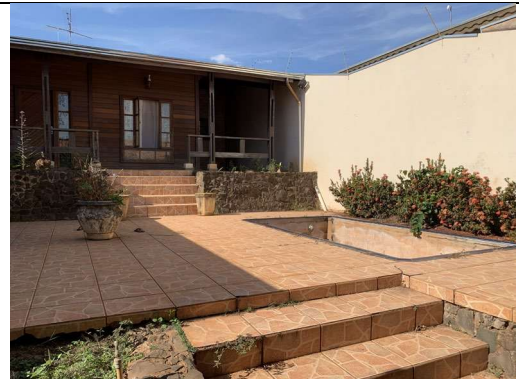
Foto 04. Casa pre fabricada de madeira tratada
