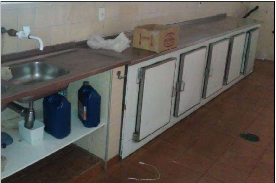
ITEM 2,008 - VISTA DO BALCÃO EM INOX SOBRE FRIGORÍFICO DA MARCA INCOMAR
