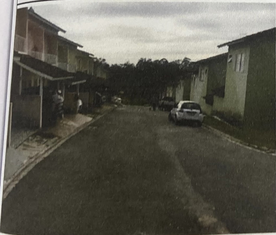
FOTO 05 - ARRUAMENTO COND. ÁGUAS DA COLINA
