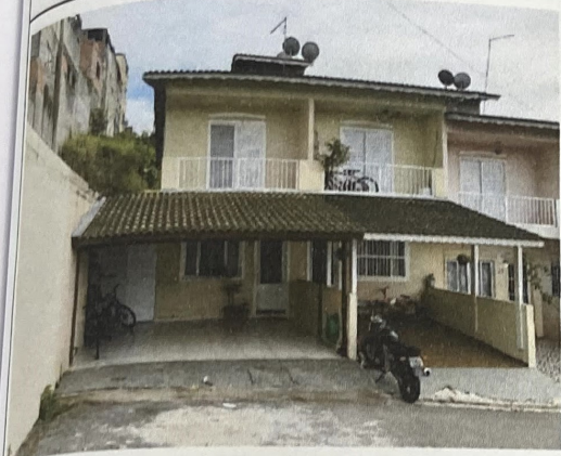
FOTO 03 - FACHADA CASA 33 V.2
