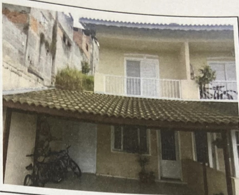
FOTO 02 - FACHADA CASA 33 V.1
