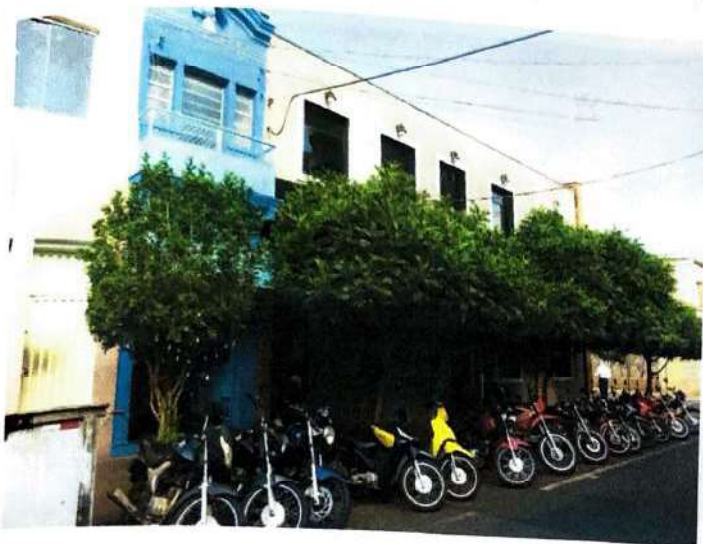
Foto 03: Vista da rua onde se localiza o imóvel – Rua Américo Brasiliense
