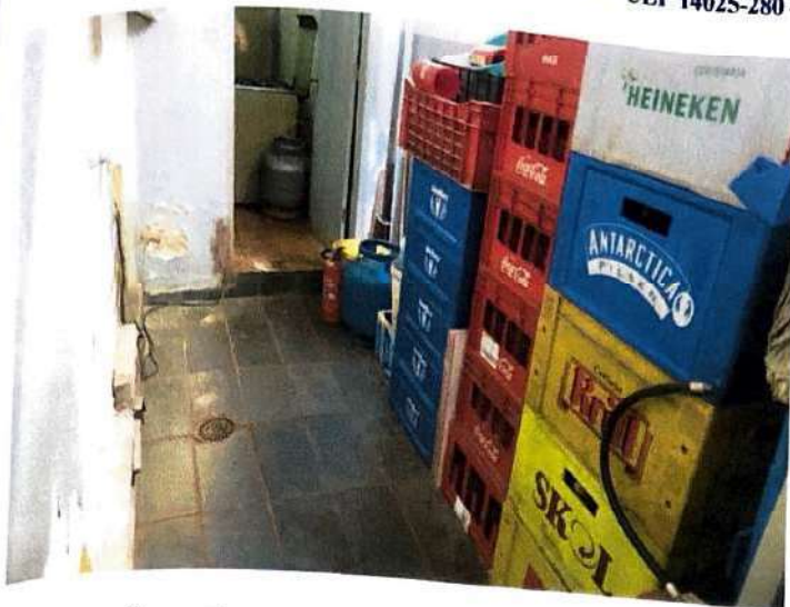
Foto 17: Área de serviços no térreo
