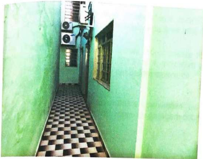
Foto 20: Corredor lateral descoberto externo
