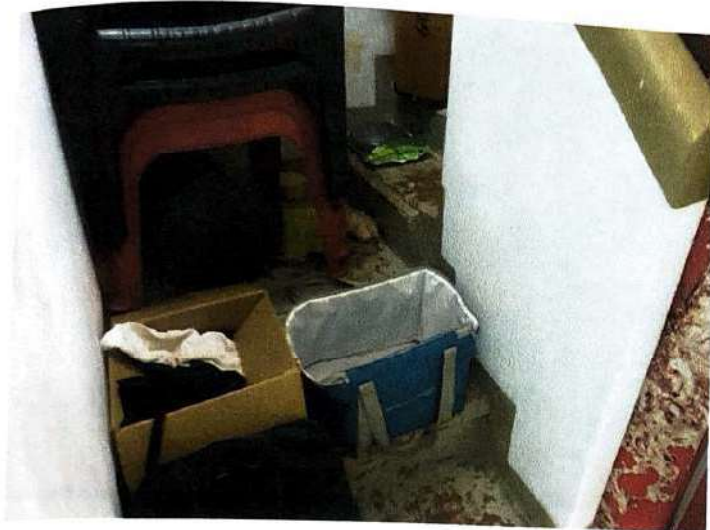
Foto 18: Escada de acesso ao pavimento superior
