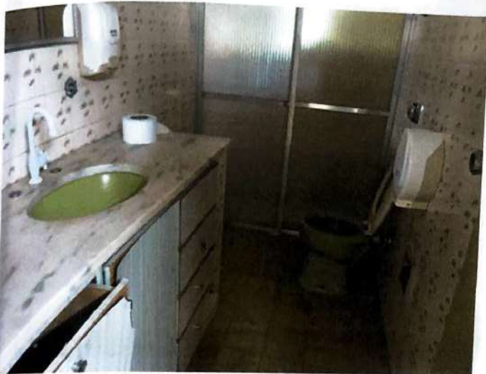
Foto 11: Banheiro do pavimento inferior
