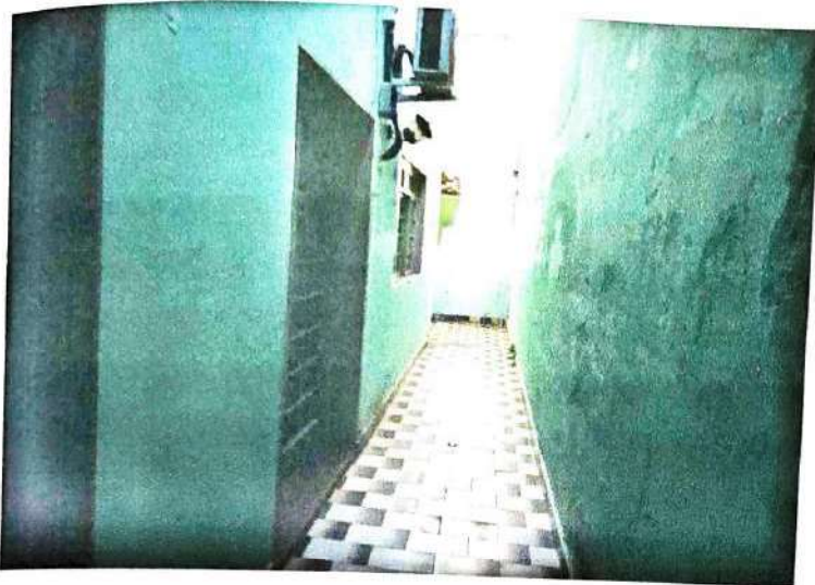
Foto 14: Corredor lateral descoberto externo
