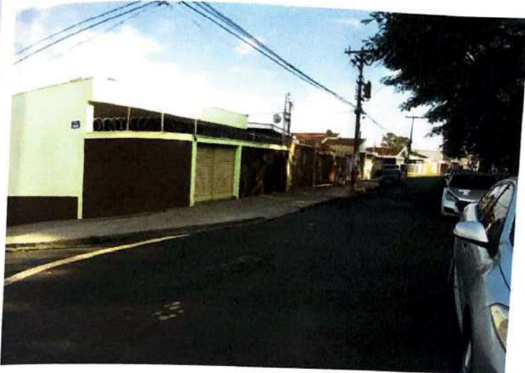
Foto 05: Vista do imóvel a partir da Rua Victor Rebouças
