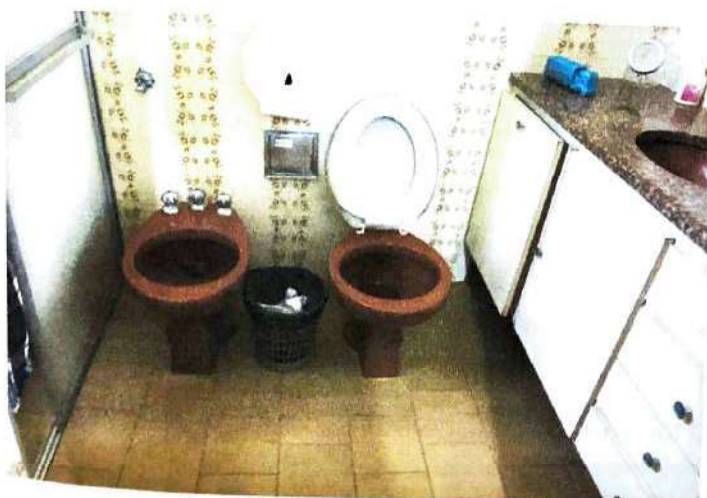
Foto 18: Banheiro social do térreo
