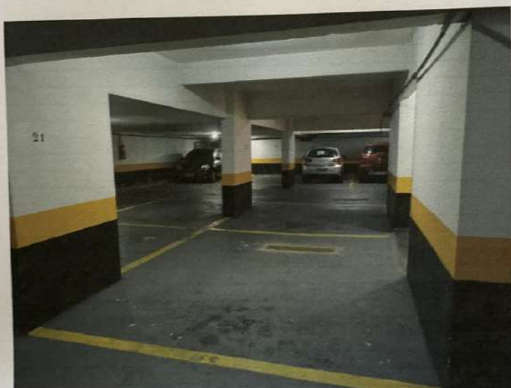
Foto nº 9 – Outra vista parcial do subsolo.
