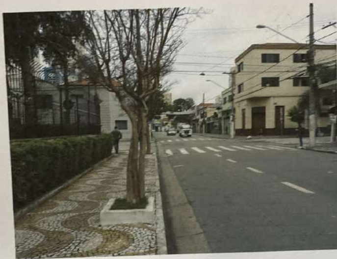
Foto nº 1 – Vista parcial da Rua Herval, onde se localiza o imóvel de matrícula nº 61.609 avaliado no presente laudo.
