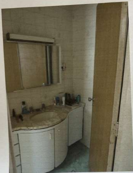
Foto nº 18 – Outra vista parcial do banheiro suite.
