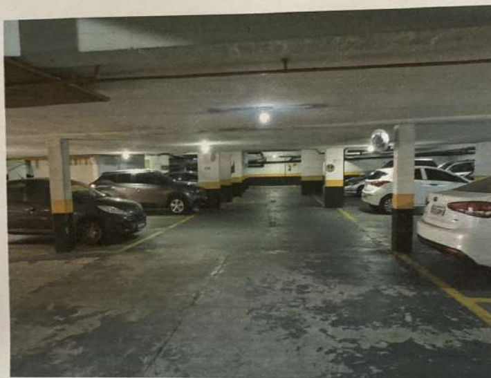
Foto nº 8 – Vista parcial do subsolo do condomínio.
