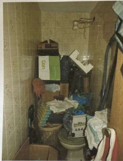
Foto nº 26 – Vista do banheiro de serviço.
