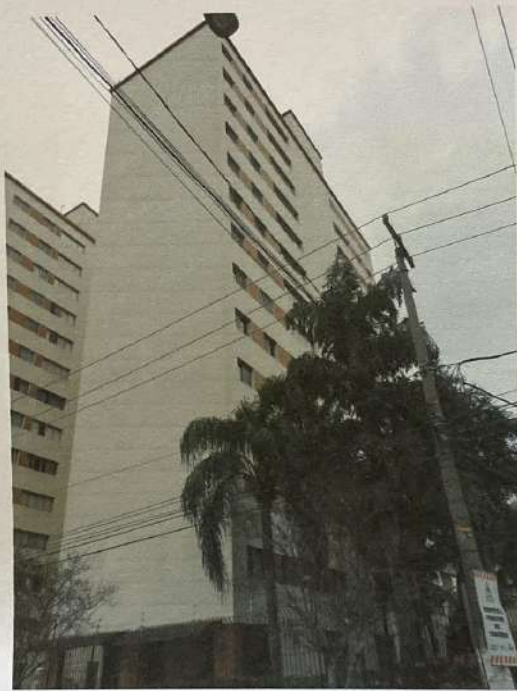
Foto nº 4 – Outra vista parcial da fachada do Edifício Itaici.
