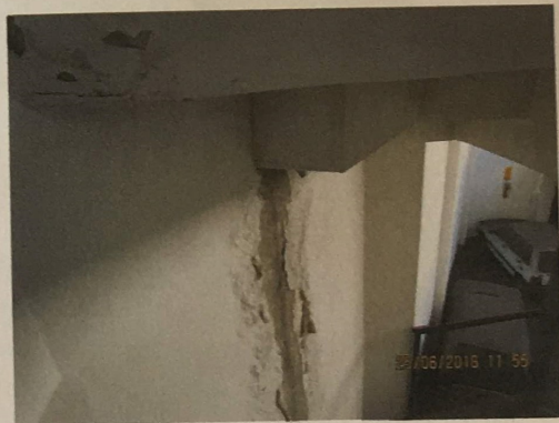
infiltração em paredes
