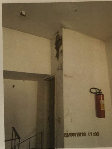
Trechos de parede e teto com infiltração
