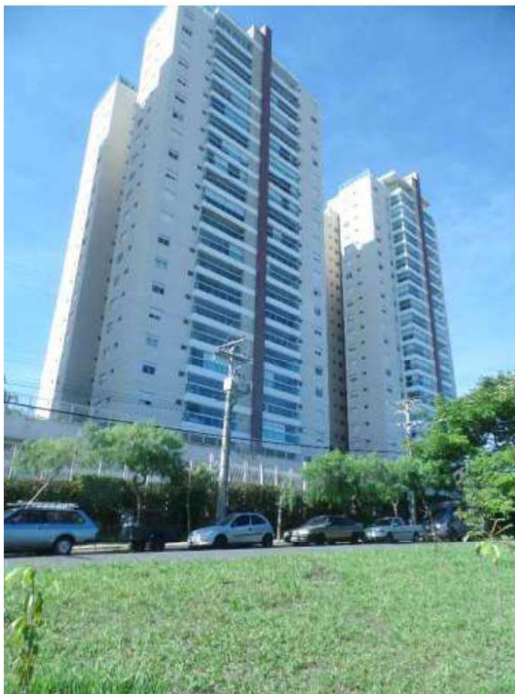
FOTO N.º 02- Detalhe externo da fachada lateral do imóvel avaliando.
