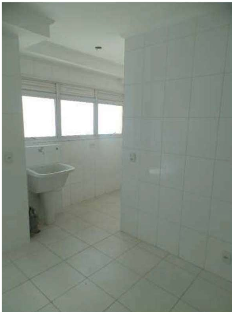
FOTO N.º 30- Aspecto da área de serviço.
