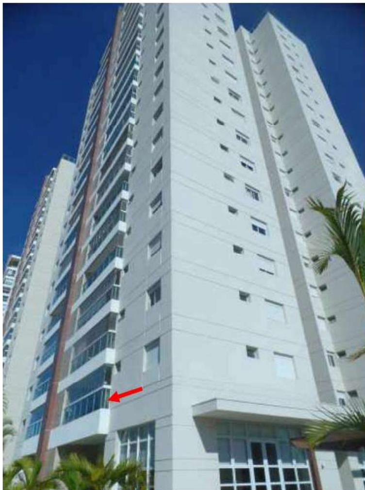
FOTO N.º 11- Vista do posicionamento do imóvel avaliando.
