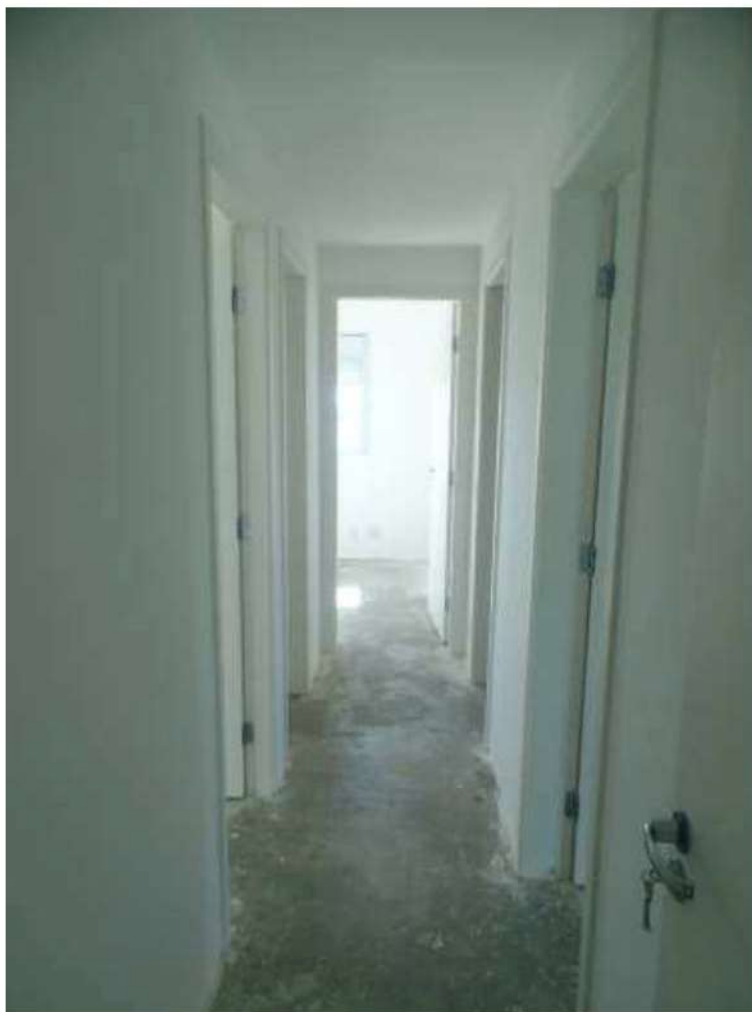
FOTO N.º 22- Aspecto do corredor de circulação para acesso aos dormitórios.
