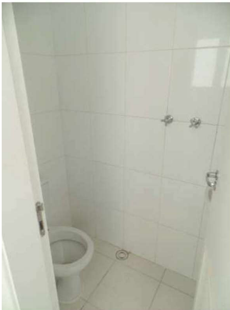
FOTO N.º 32- Vista do banheiro da área de serviço.
