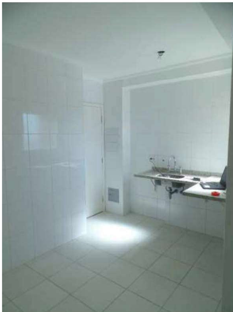
FOTO N.º 31- Detalhe interno da área de serviço.
