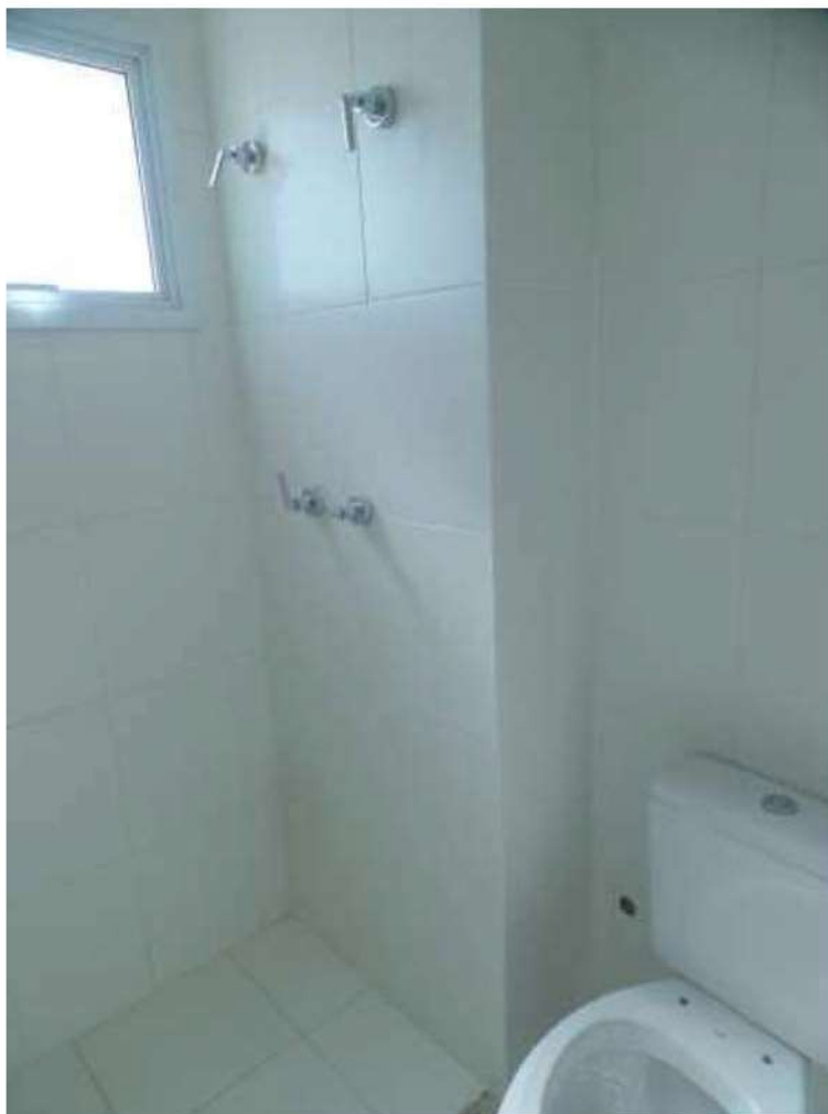
FOTO N.º 27- Detalhe interno do banheiro do dormitório de n.º 03.
