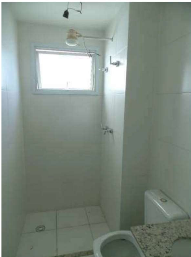
FOTO N.º 28- Vista interna do banheiro social.
