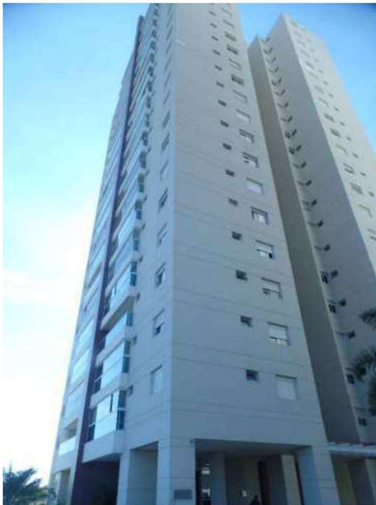
FOTO N.º 08- Tomada frontal do Edifício Paraty do imóvel avaliando.
