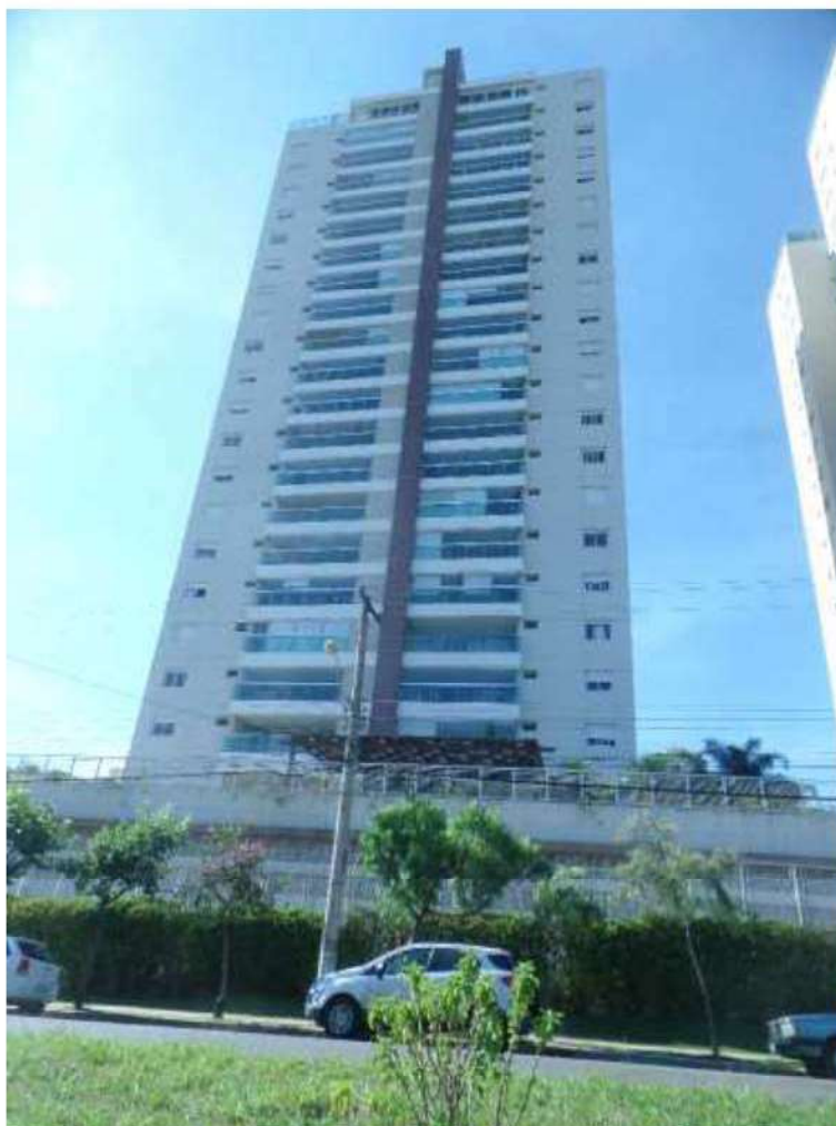
FOTO N.º 03- Vista externo da fachada frontal do imóvel avaliando.
