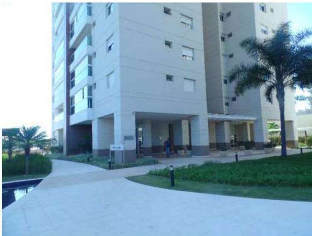
FOTO N.º 09- Aspecto das partes comuns do Edifício Paraty do imóvel avaliando.
