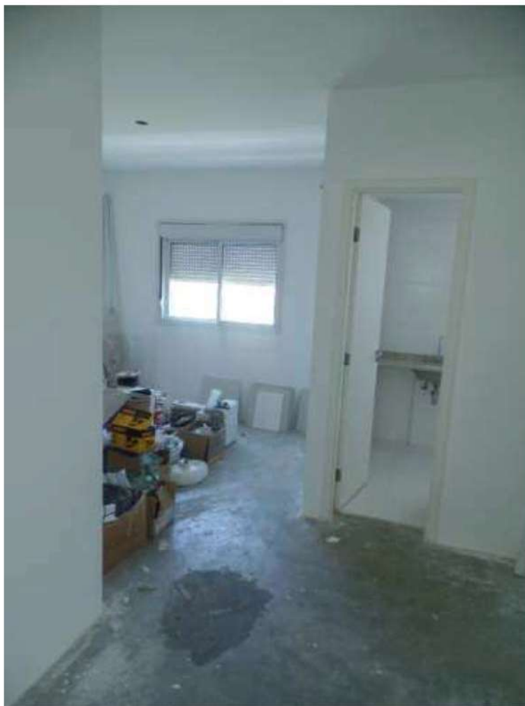
FOTO N.º 24- Vista do dormitório de n.º 02 com banheiro.
