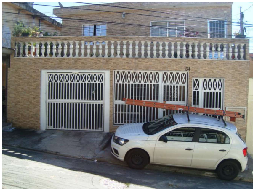
Foto nº. 2- Vista da frente do imóvel
