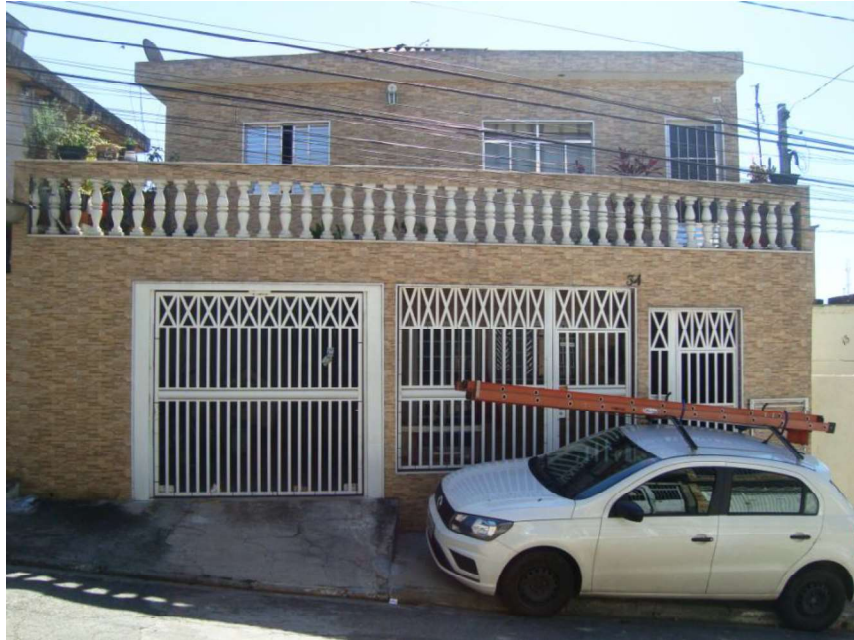
Foto nº. 1- Vista da frente do imóvel
