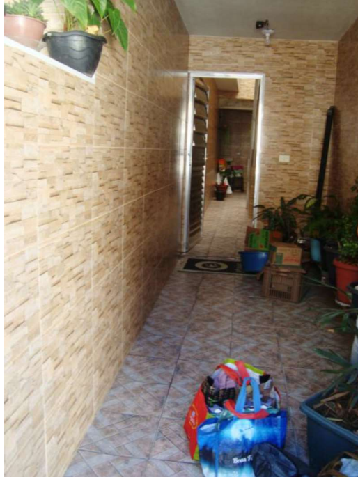
Foto nº 9 - Vista do acesso ao pavimento superior
