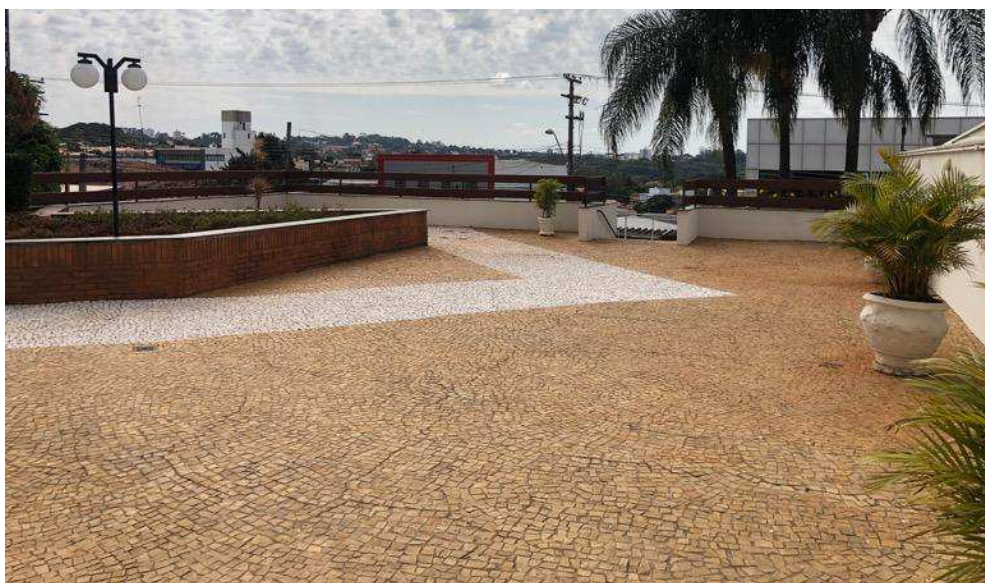
Imagem 07: Pátio em frente ao edifício, com escada de acesso a portaria no nível da rua
