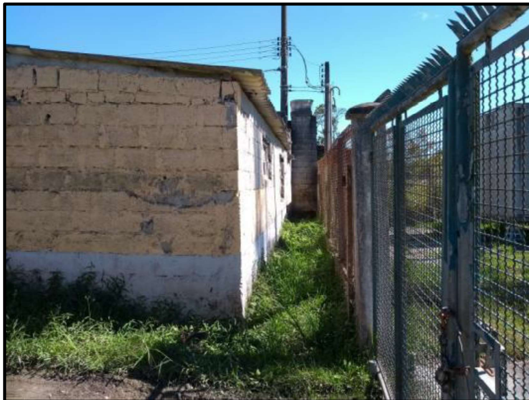
EDIFICAÇÃO DA MARMORARIA (ESQUERDA), PORTÃO DE ACESSO AO LOCAL EM QUE ESTÁ INSTALADA A ANTENA DE TRANSMISSÃO (DIREITA).
