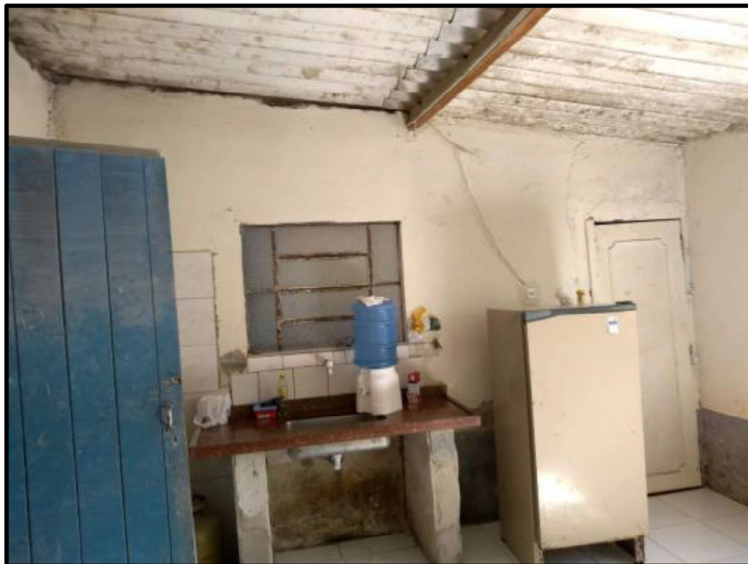
VISTA DA COZINHA.
