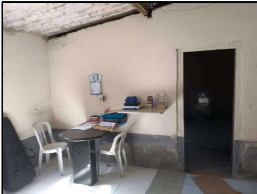
VISTA DA COZINHA.
