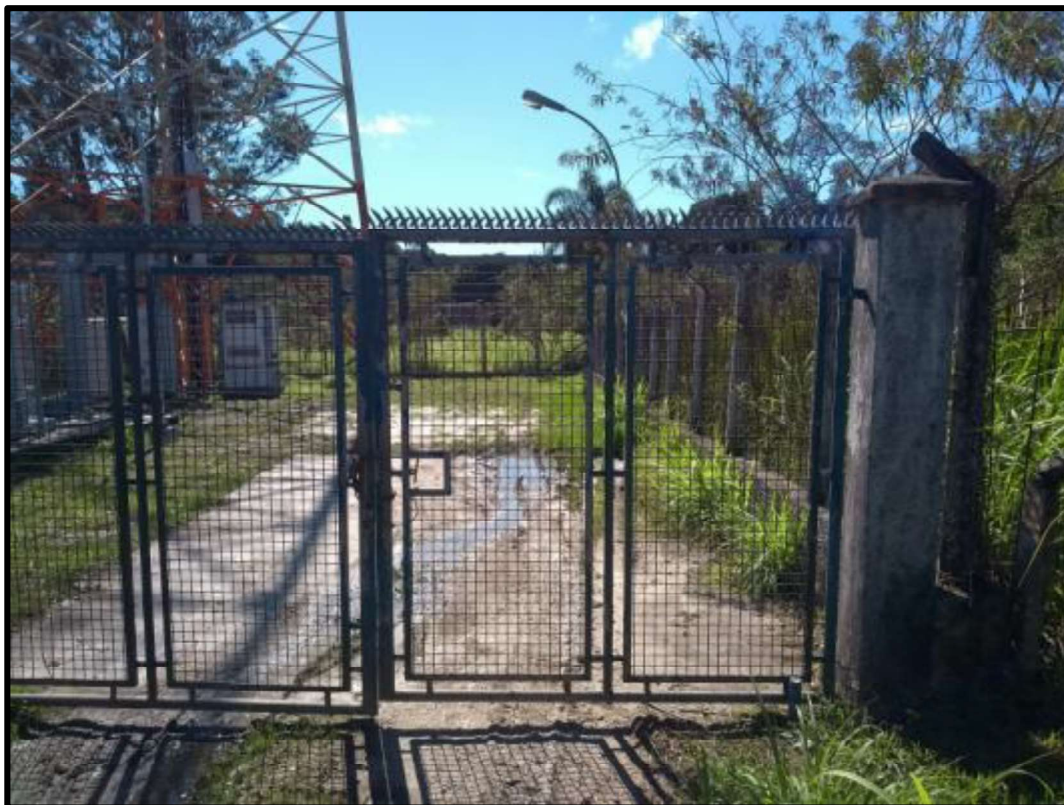
PORTÃO DE ACESSO AO LOCAL EM QUE ESTÁ INSTALADA A ANTENA DE TRANSMISSÃO.
