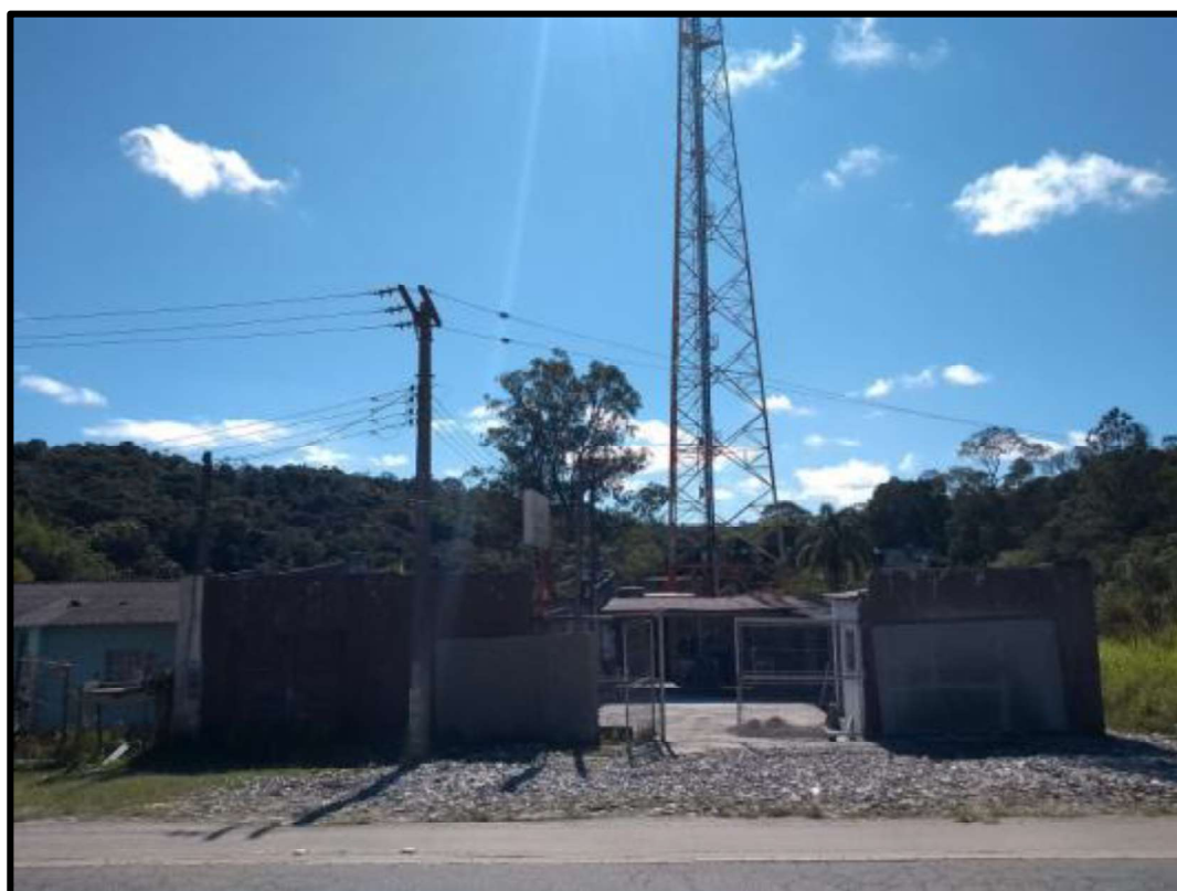
Vista da fachada do Imóvel Avaliando.
