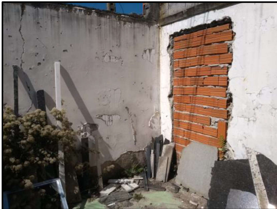
VISTA INTERNA DO CÔMODO EM RUÍNAS EXISTENTE NO LOCAL.
