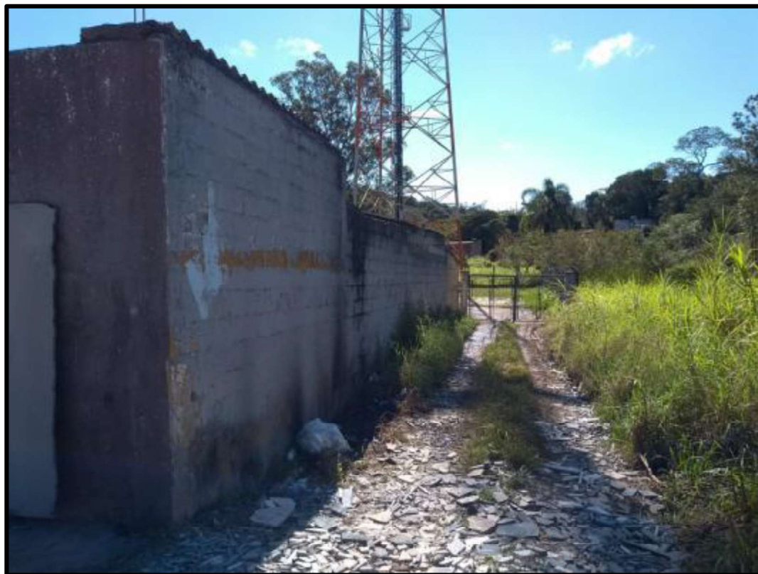
CAMINHO DE ACESSO AOS FUNDOS DO TERRENO, LOCAL EM QUE ESTÁ INSTALADA A ANTENA DE TRANSMISSÃO.
