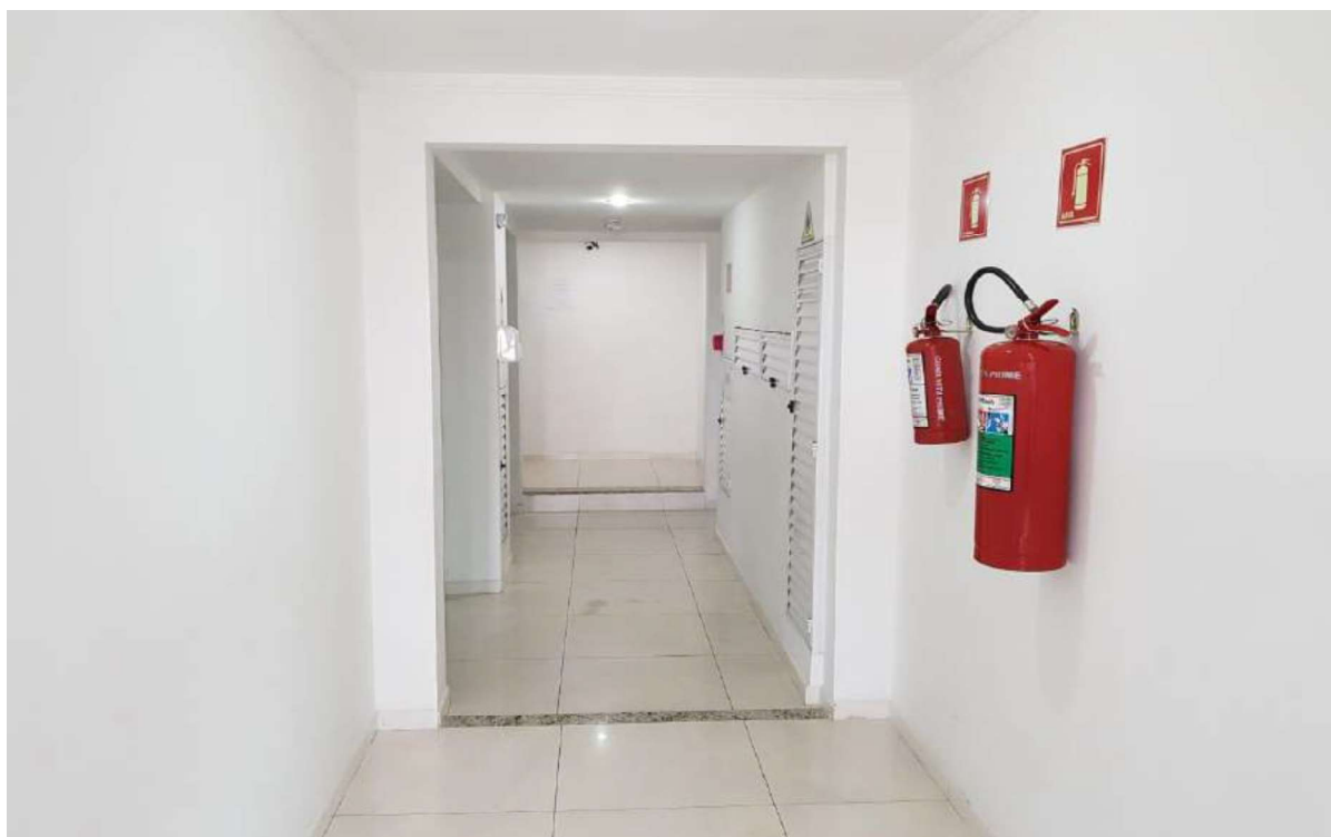
Foto 31 – Hall de elevadores da cobertura
