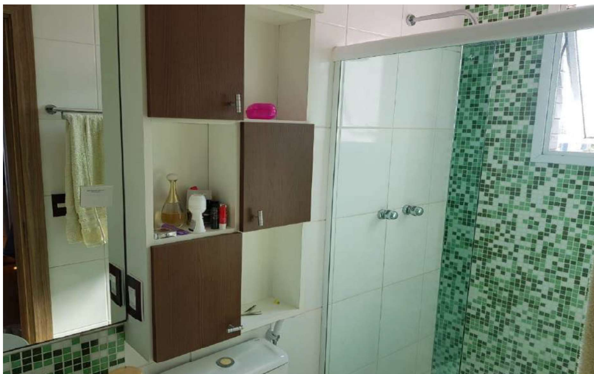
Foto 16 – Banheiro do dormitório 1
