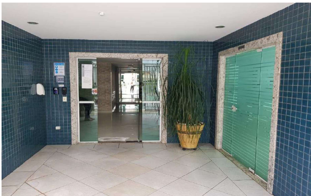
Foto 5 – Hall de entrada – à direita porta de acesso ao salão de festas
