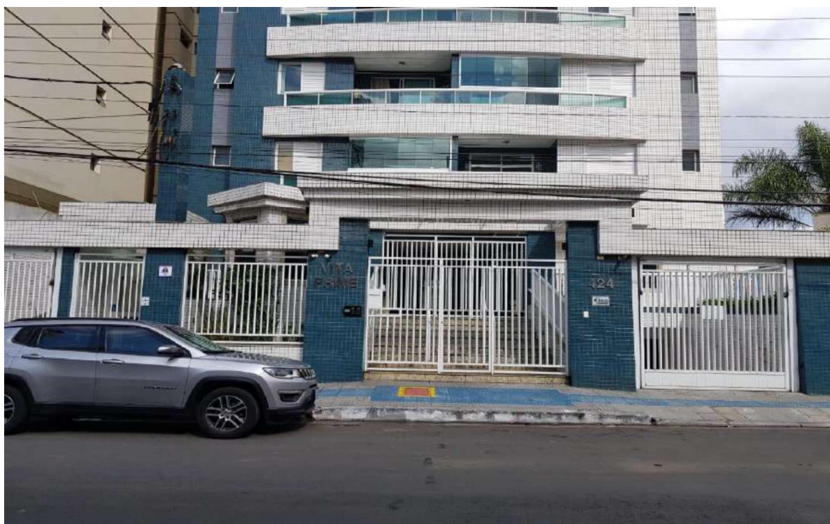
Foto 3 – Portaria – lado externo – acesso de pedestres e veículos
