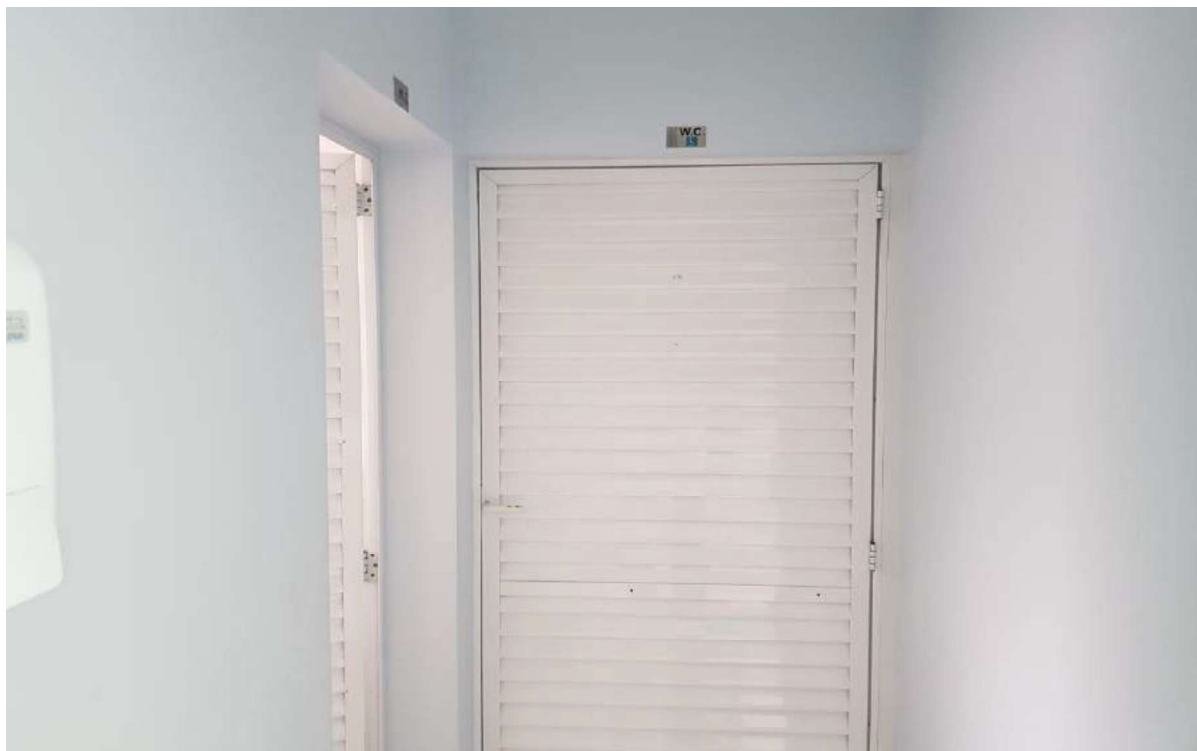
Foto 52 – Salão de festas – banheiros
