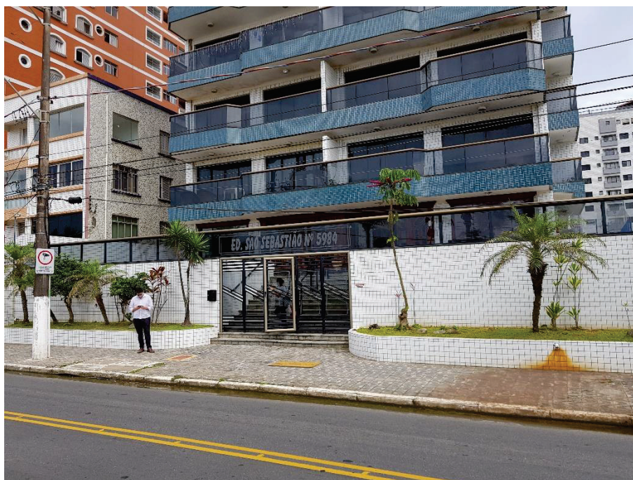
Foto 3 - Vista geral da fachada do Edifício São Sebastião.
