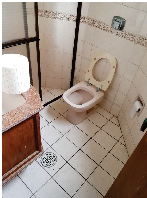
Foto 28 - Unidade nº 202: Vista geral do banheiro do dormitório (suíte).
