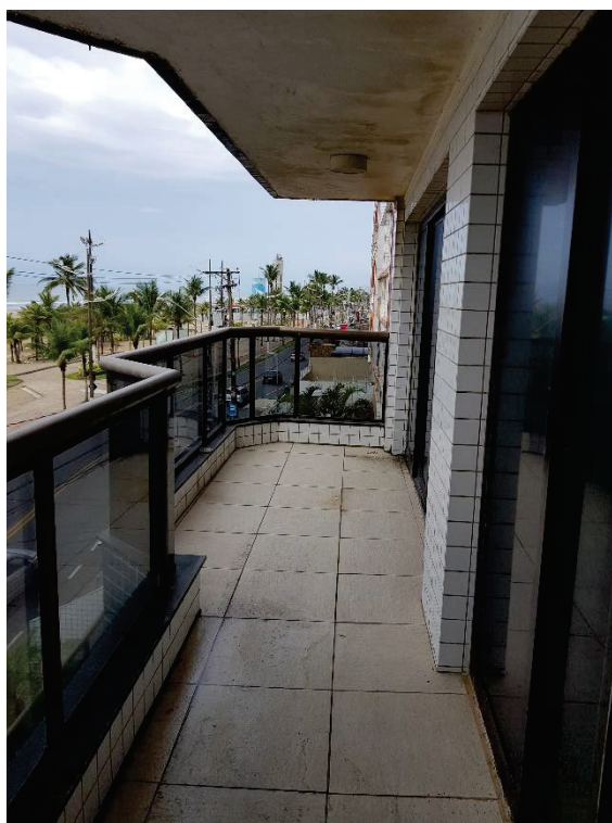
Foto 25 - Unidade nº 202: Vista geral da sacada da sala.
