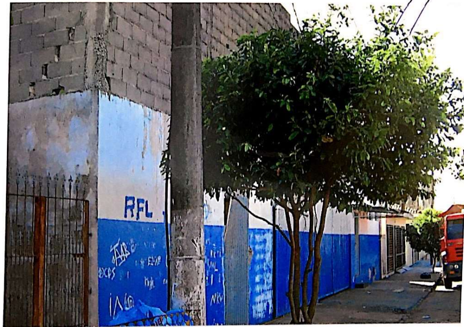
FOTO 1 Vista geral da frente do imóvel, a partir da esquina das Ruas das Açucenas e Carlos Kielander. Foto tomada no sentido decrescente da numeração da Rua das Açucenas
