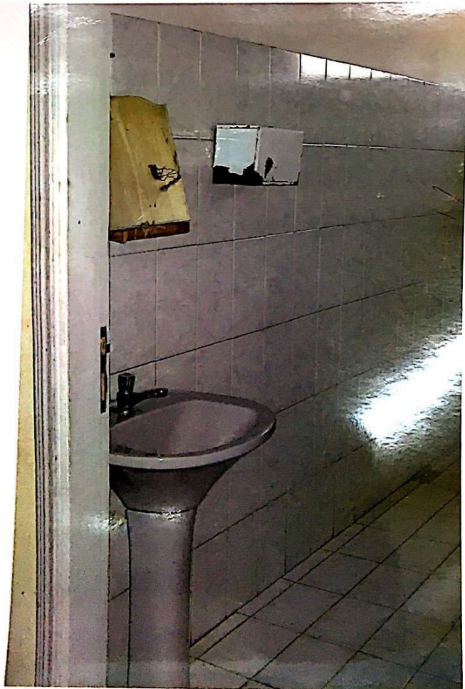
FOTO 8 Detalhe de um dos sanitários
