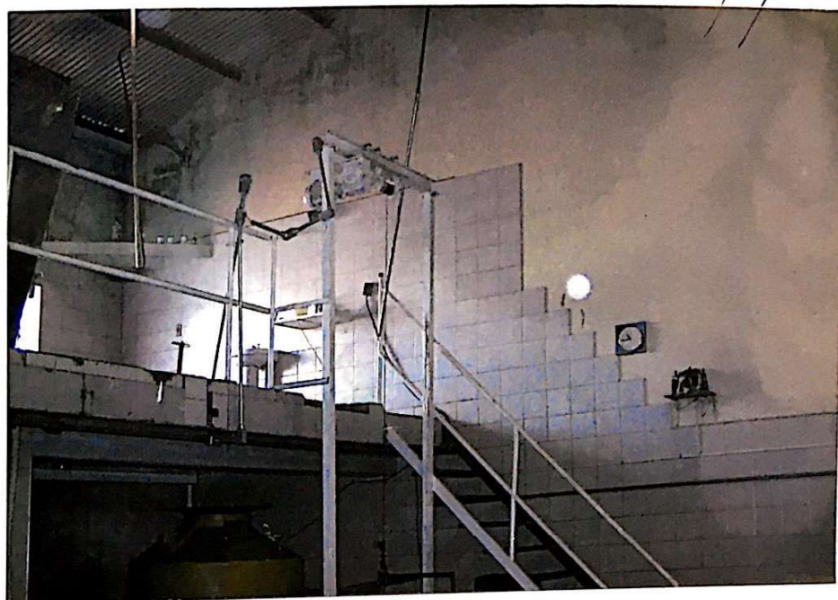
FOTO 5 Interior do "galpão de equipamentos"
