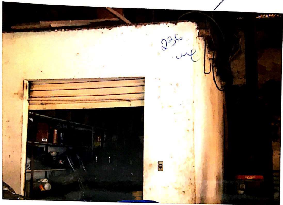
FOTO 13 MATRÍCULAS 10.868 e 14.940: Detalhe do depósito, aparecendo a sua porta de entrada.
