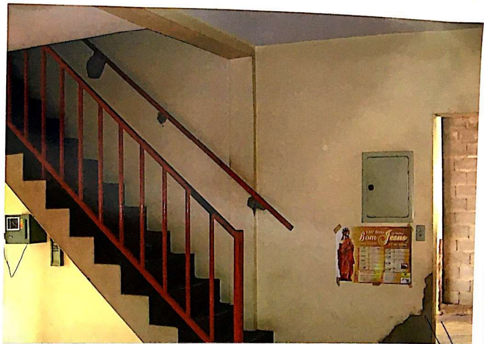
FOTO 7 Bloco do escritório, detalhe interno do hall de entrada
