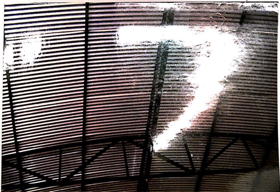
FOTO 10 MATRÍCULAS 10.868 e 14.940: Detalhe da cobertura existente sobre todo o imóvel
