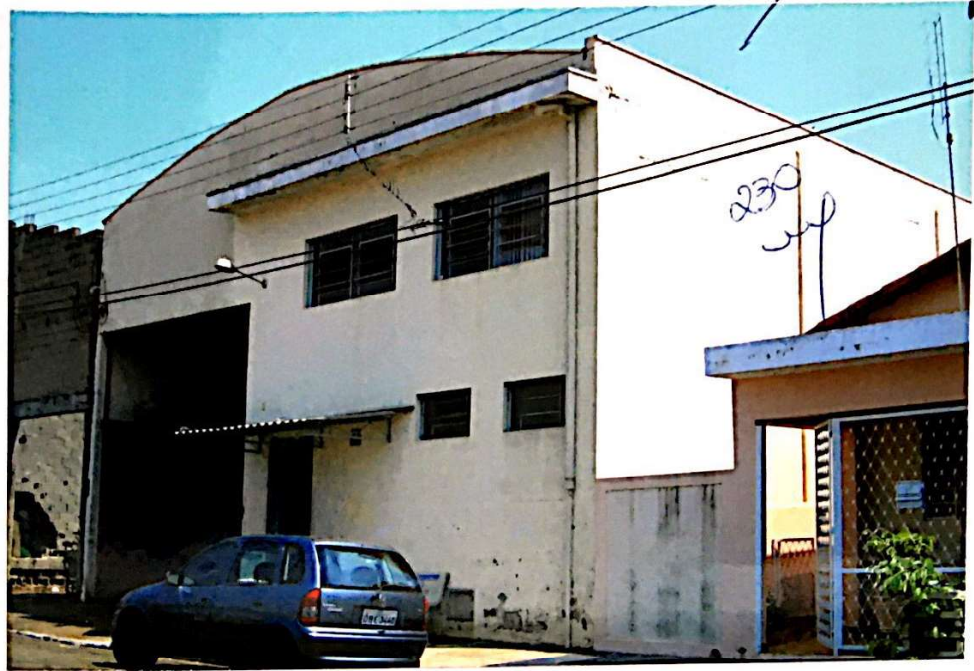
FOTO 7 MATRÍCULAS 10.868 e 14.940: Vista frontal do imóvel, mostrando em primeiro plano o bloco do escritório, com dois pavimentos e a cobertura em arco por cima.
