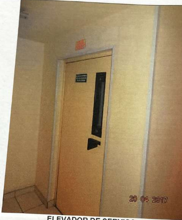
ELEVADOR DE SERVIÇO
