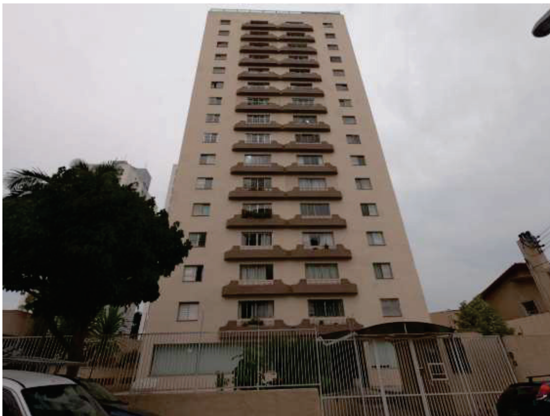
Foto 1. Frente do Edifício.
