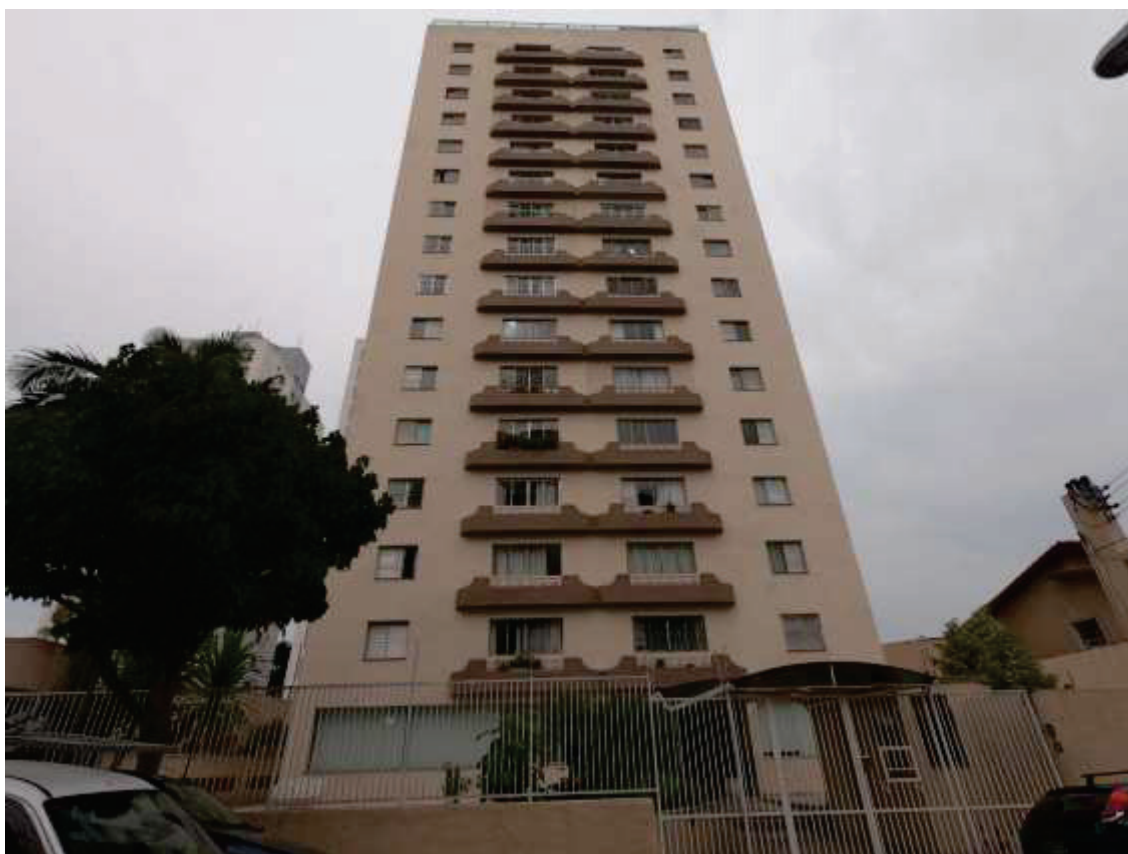
Foto 1. Frente do Edifício.
