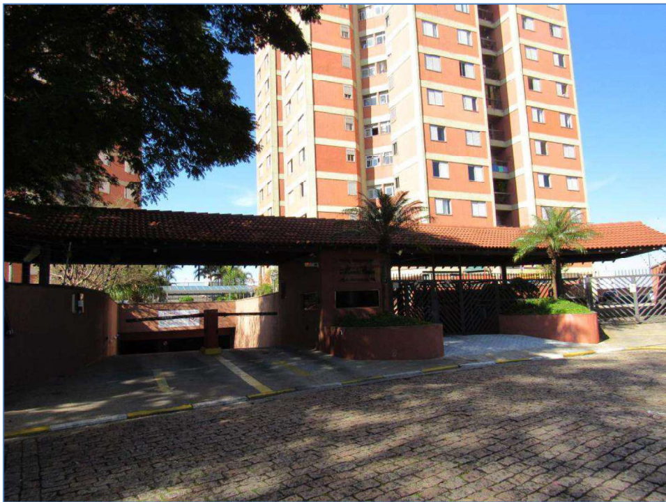
TRECHO DA PRAÇA UNIVERSO, ONDE SE ENCONTRAM LOCALIZADOS OS IMÓVEIS.
