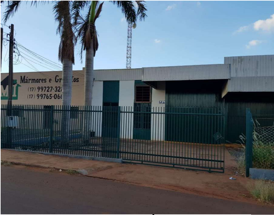
FOTO 01 – VISTA FRONTAL IMÓVEL VISTA DA RUA
