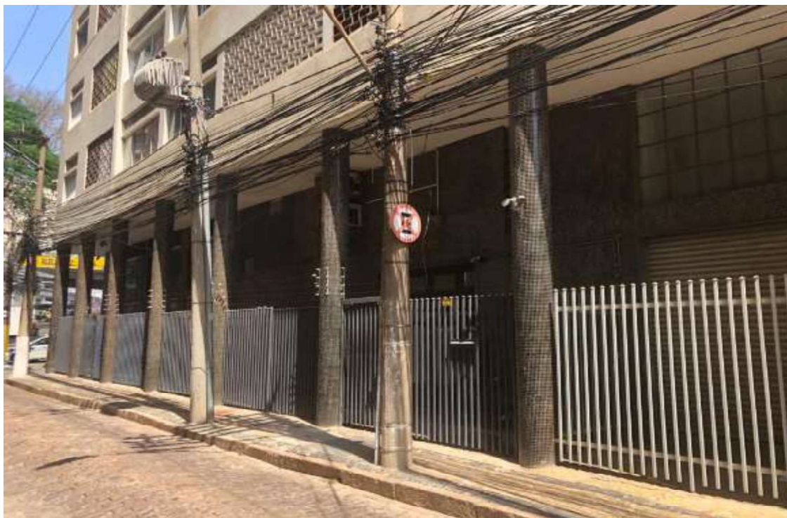
Visão da entrada nos moradores
