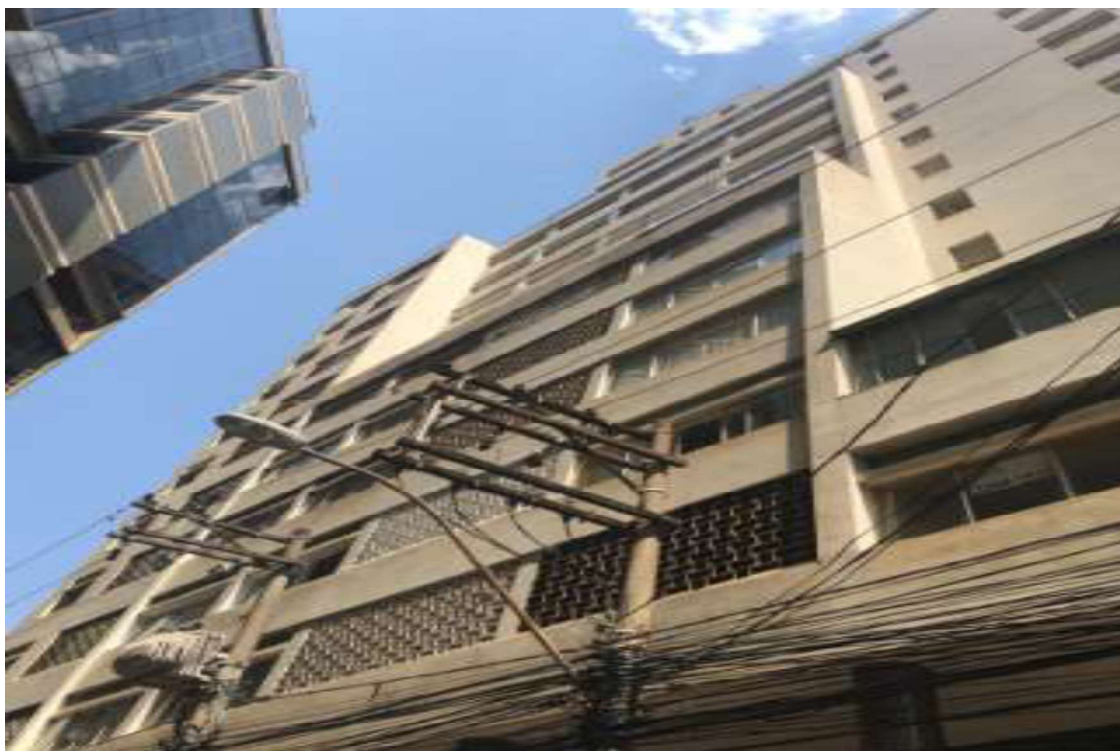
Fachada no edifício
