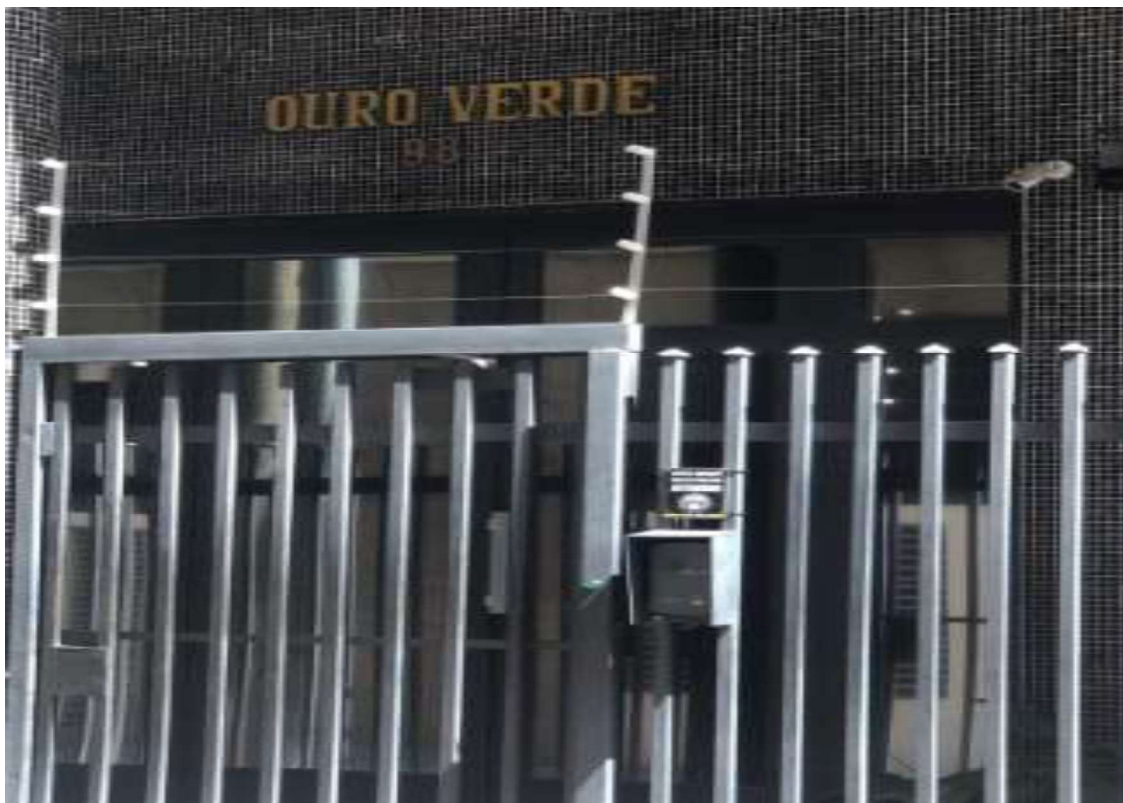
Indicação do edifício
