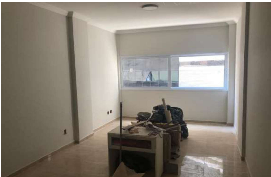
Quarto amplo – em reforma
