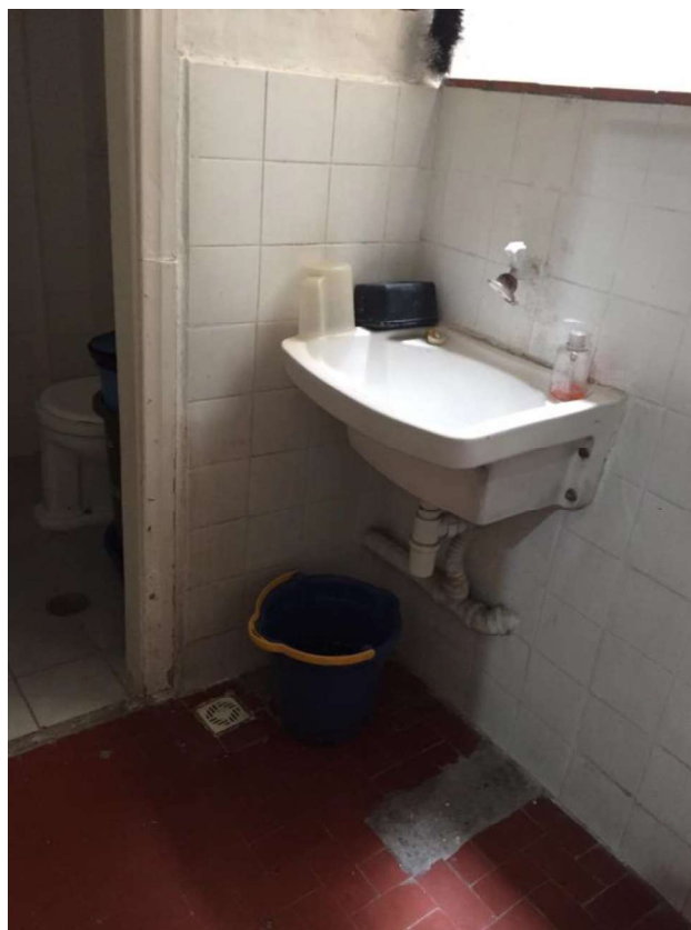
Foto 06 – Área de serviços
