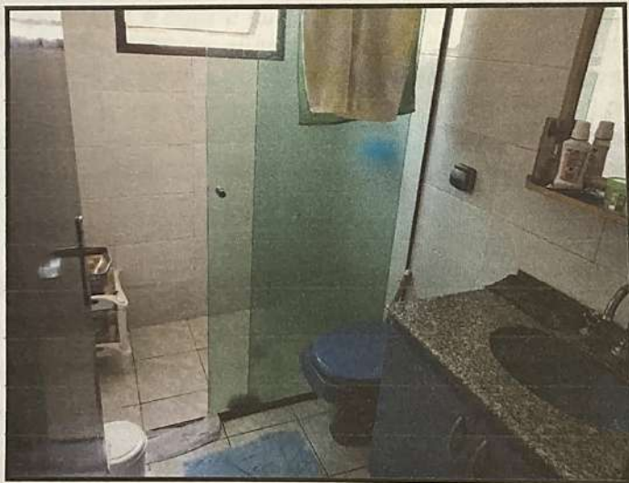
17. Pavimento superior. Vista interna do banheiro social.
