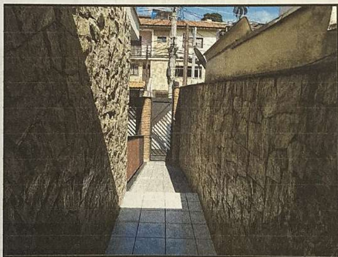
3. Vista do corredor externo de acesso à residência.
