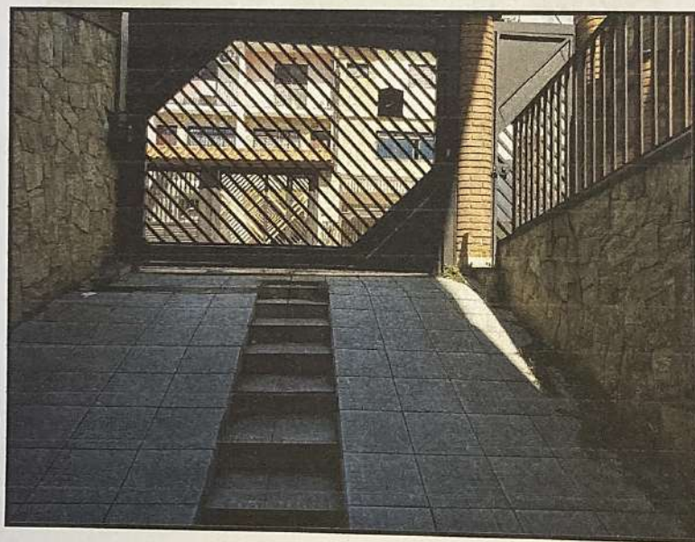
5. Vista da rampa de acesso ao subsolo a partir da Rua Tucunduva.
