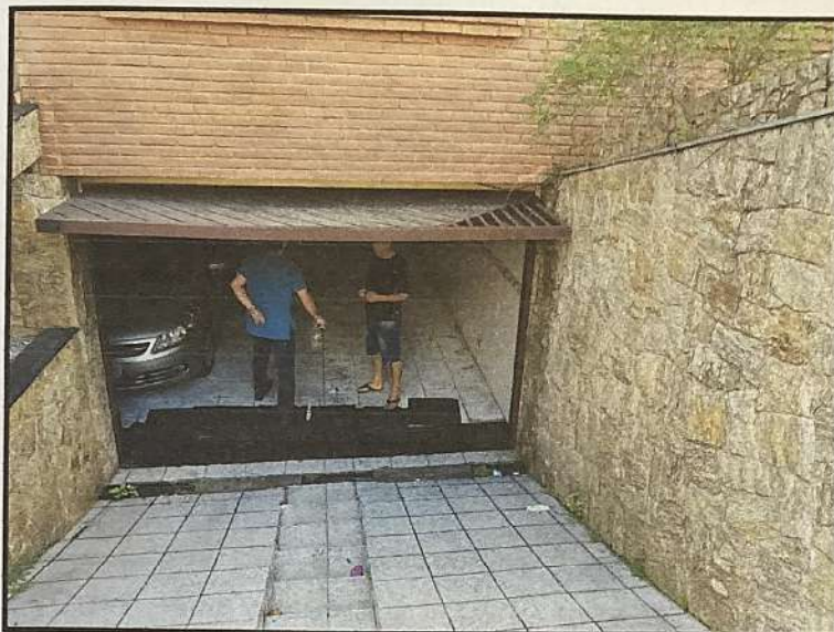
4. Vista do acesso ao subsolo (garagem).
