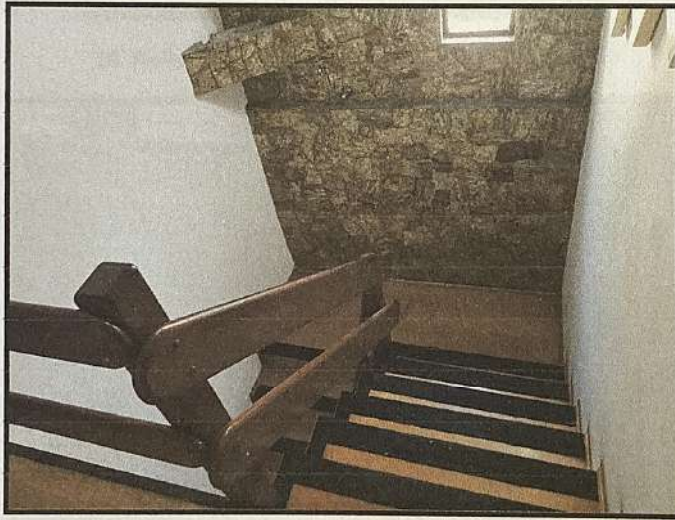
15. Vista da escada de ligação entre os pavimentos térreo e superior.
