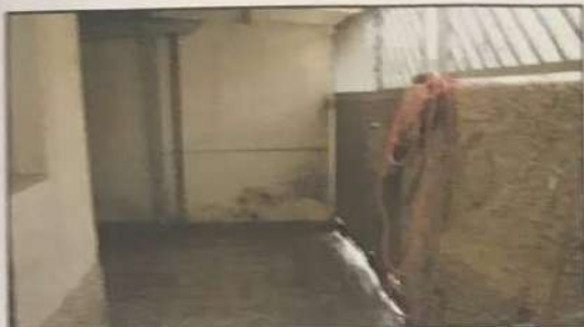
Foto 2 – Garagem vista a partir da frente do imóvel
