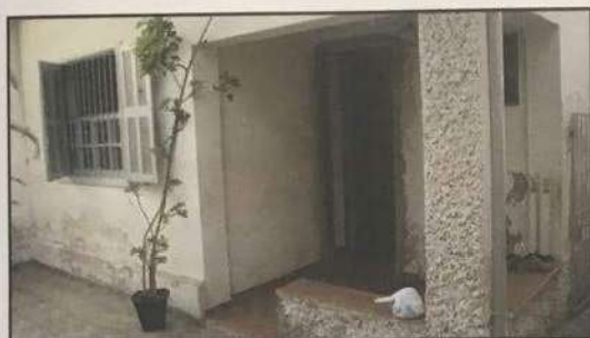
Foto 10 – Segunda edificação, localizada nos fundos do terreno.
