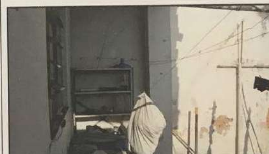
Foto 13 – Fundos do imóvel, composto de lavanderia e quintal da segunda edificação.
