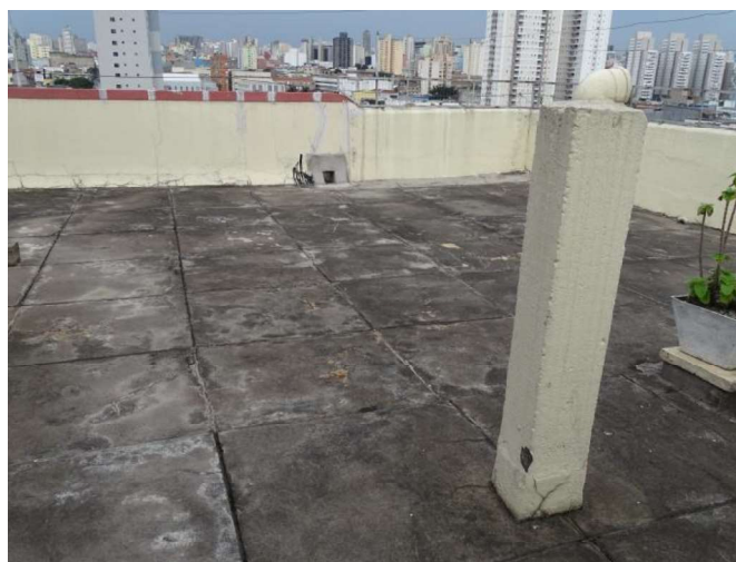
ÁREA COMUM DO TERRAÇO NO PAVIMENTO COBERTURA.
