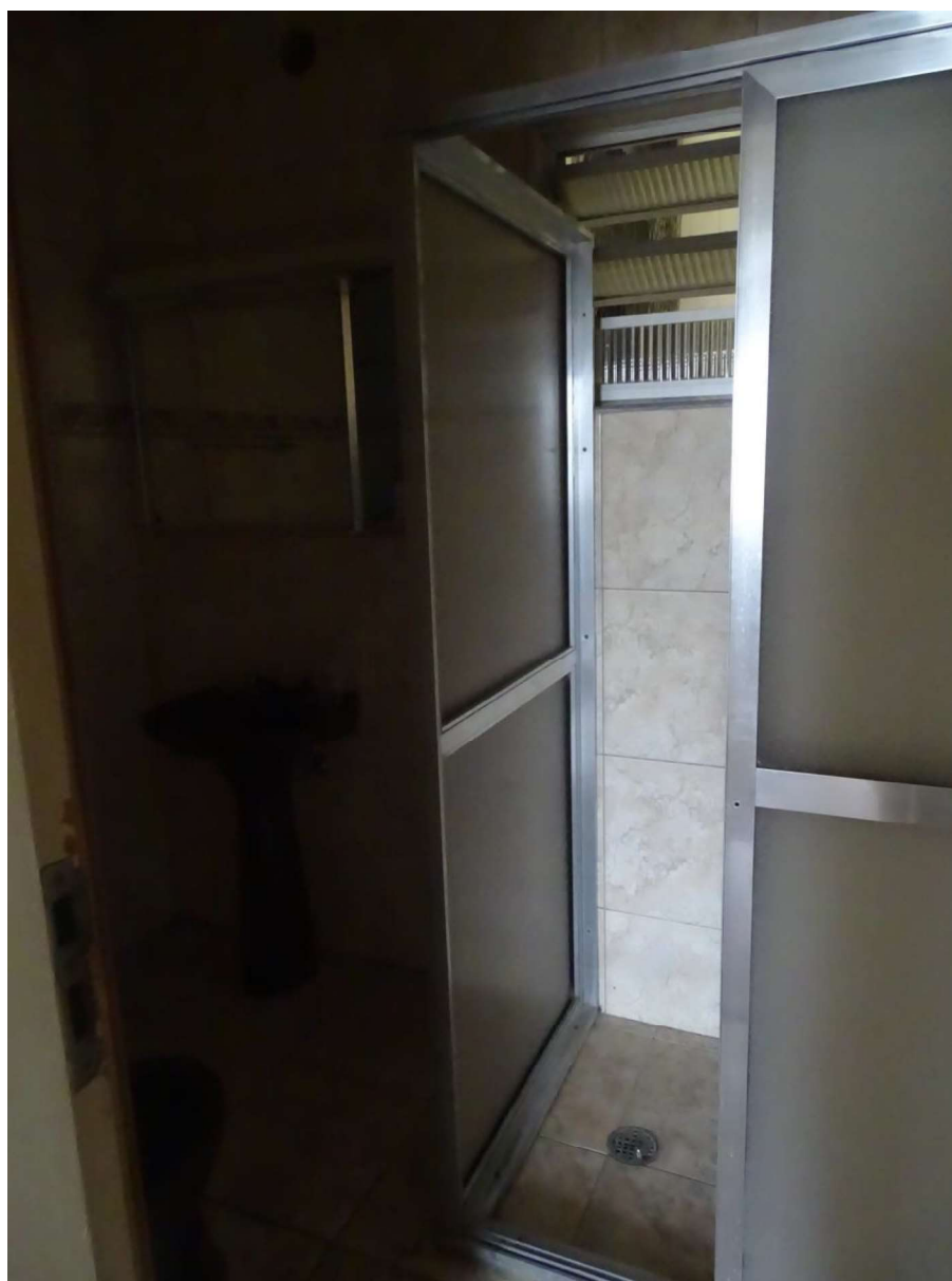
ASPECTO CARACTERISTICA DO BANHEIRO .
