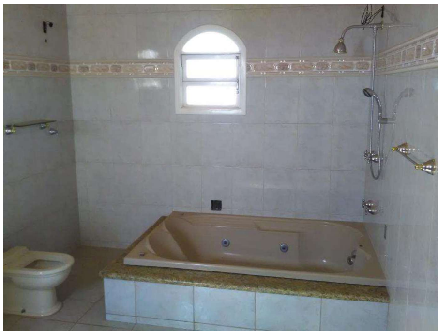
FOTO 11 – Mostrando o banheiro com hidromassagem na suite do casal
