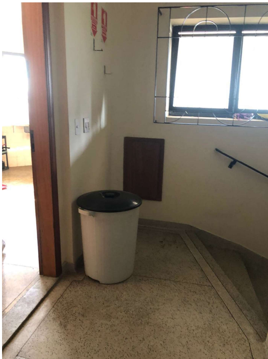
FOTO Nº 7 - Vista da entrada de serviço da unidade.
