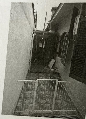
CORREDOR LATERAL EXTERNO E ESCADARIA.
