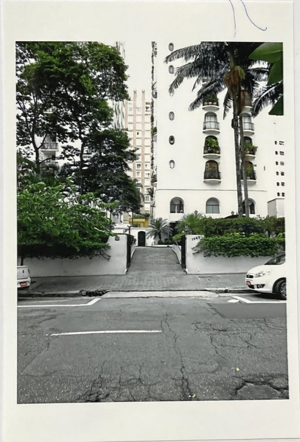
VISTA DA SAÍDA DO ESTACIONAMENTO DE VISITANTE.
