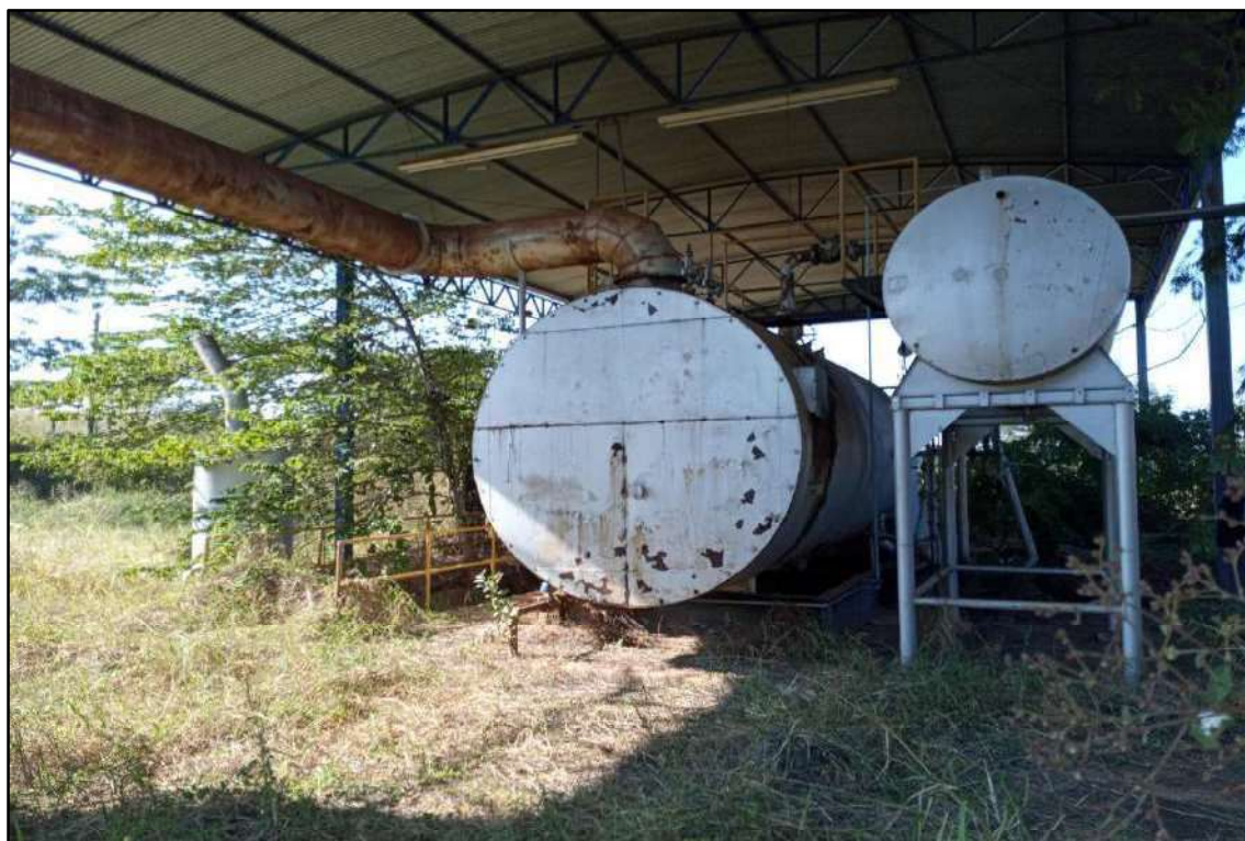
ITEM 021 - CALDEIRA DA MARCA EÔNIA, À LENHA, CAPACIDADE PARA 8.000 KG DE VAPOR/HORA.
