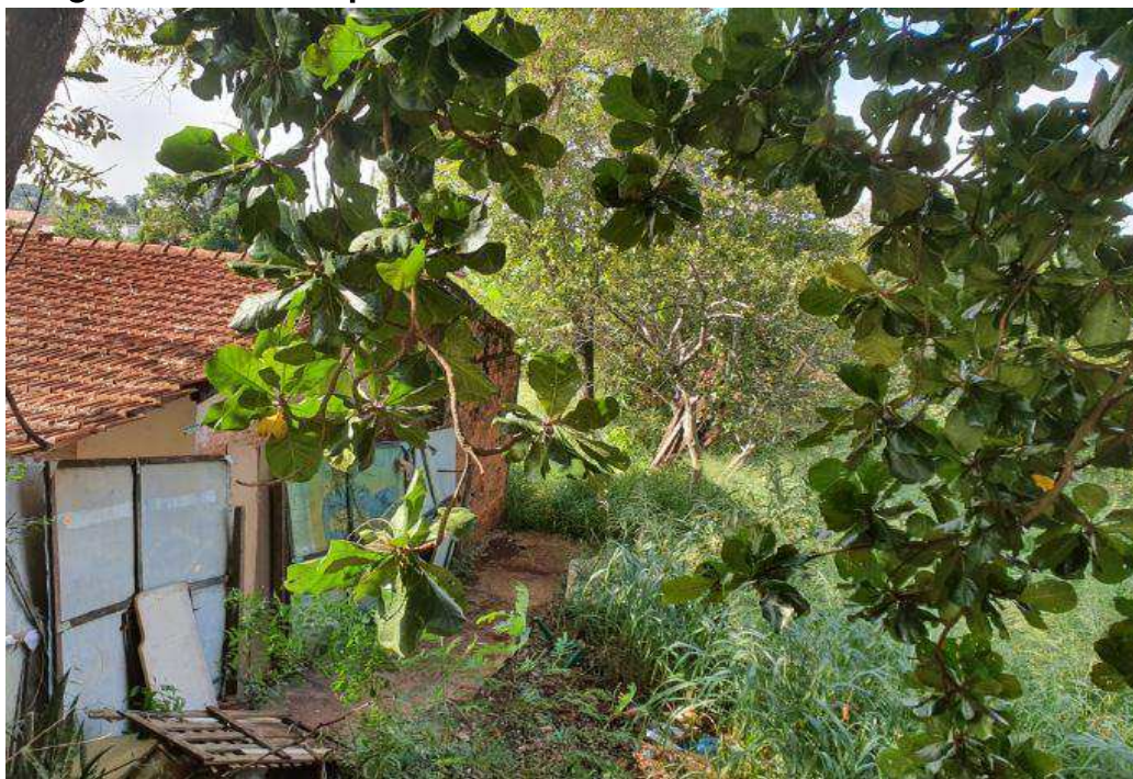
Imagem 4 – vista de parte do interior do imóvel
