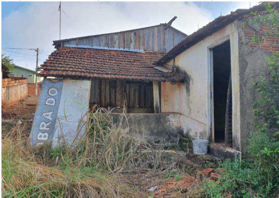
Imagem 17 – vista de parte de uma das construções existentes no imóvel
