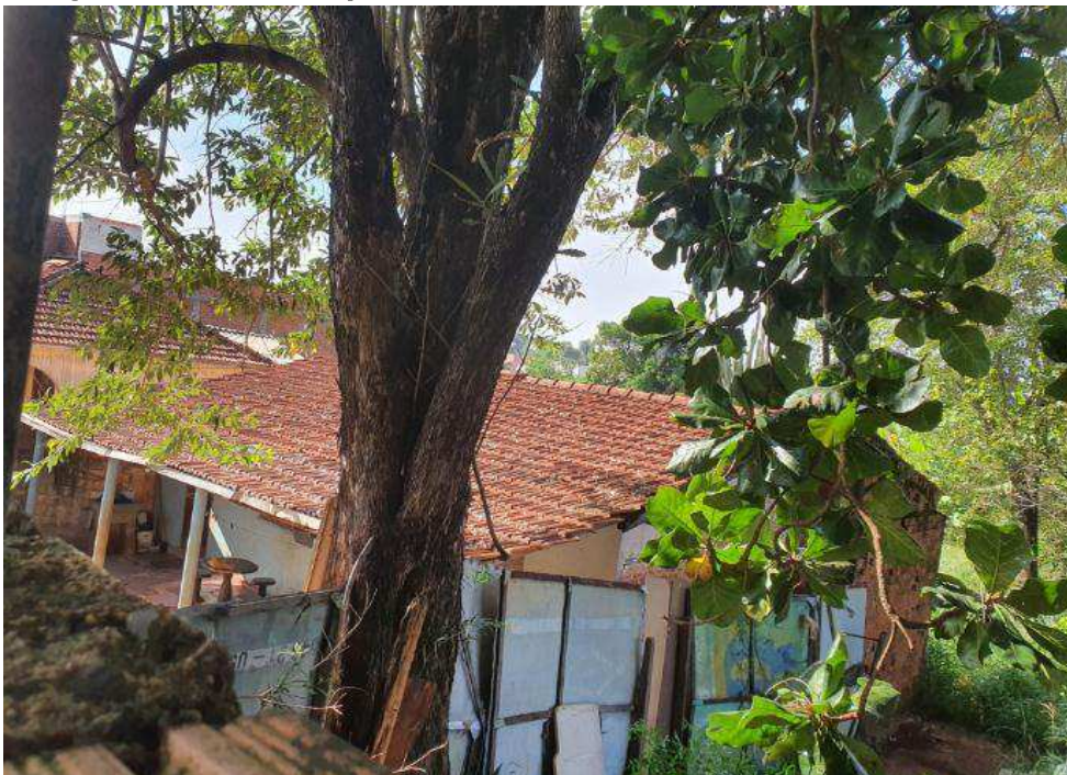
Imagem 5 – vista de parte do interior do imóvel
