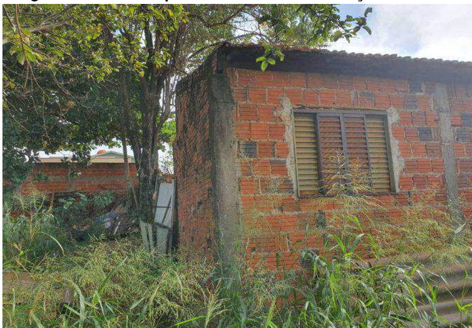
Imagem 16 – vista de parte de uma das construções
