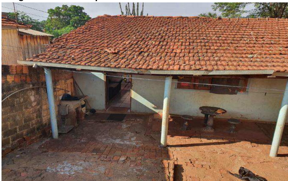
Imagem 8 – vista de parte do interior do imóvel
