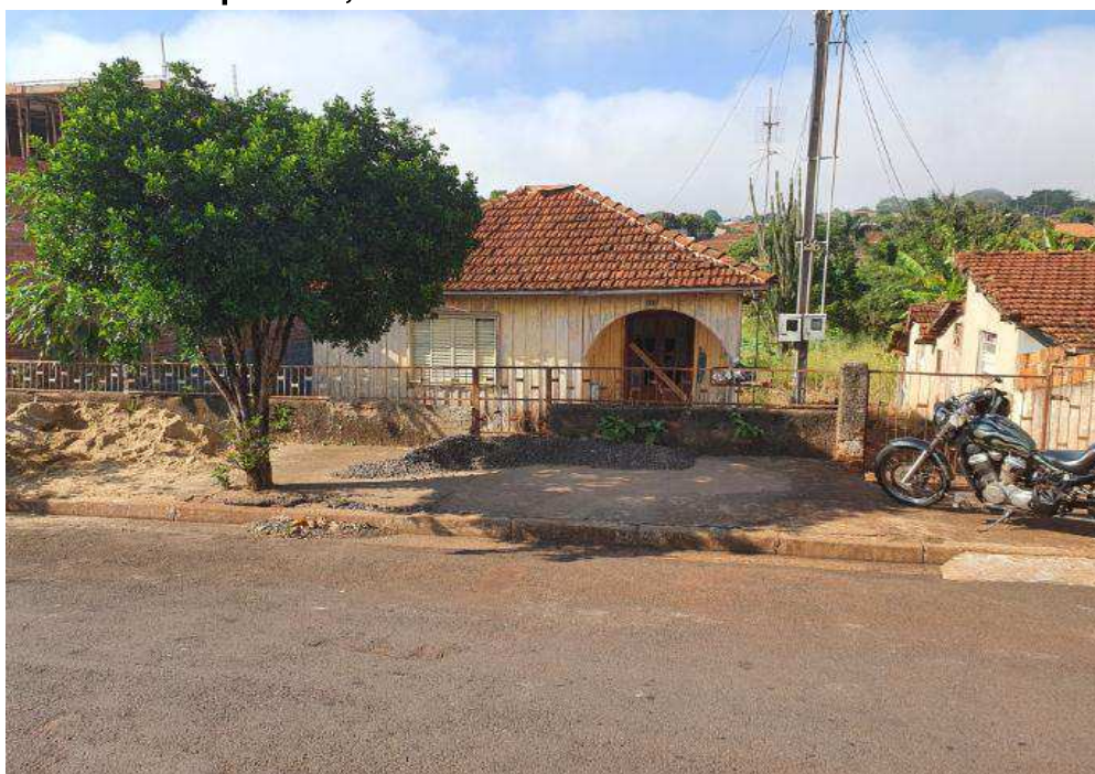
Imagem 9 – vista frontal de uma das construções do imóvel a partir da via pública, casa em madeira
