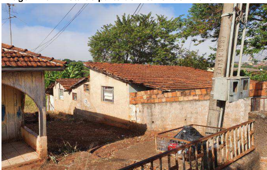
Imagem 10 – vista de parte do interior do imóvel
