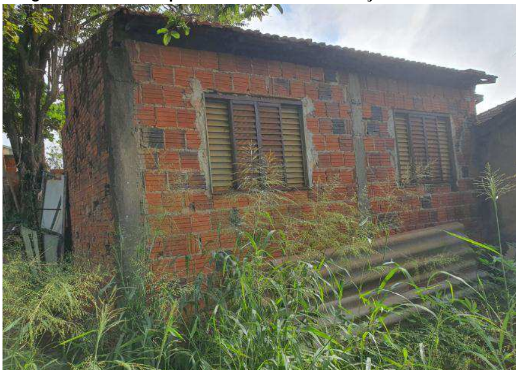
Imagem 15 – vista de parte de uma das construções
