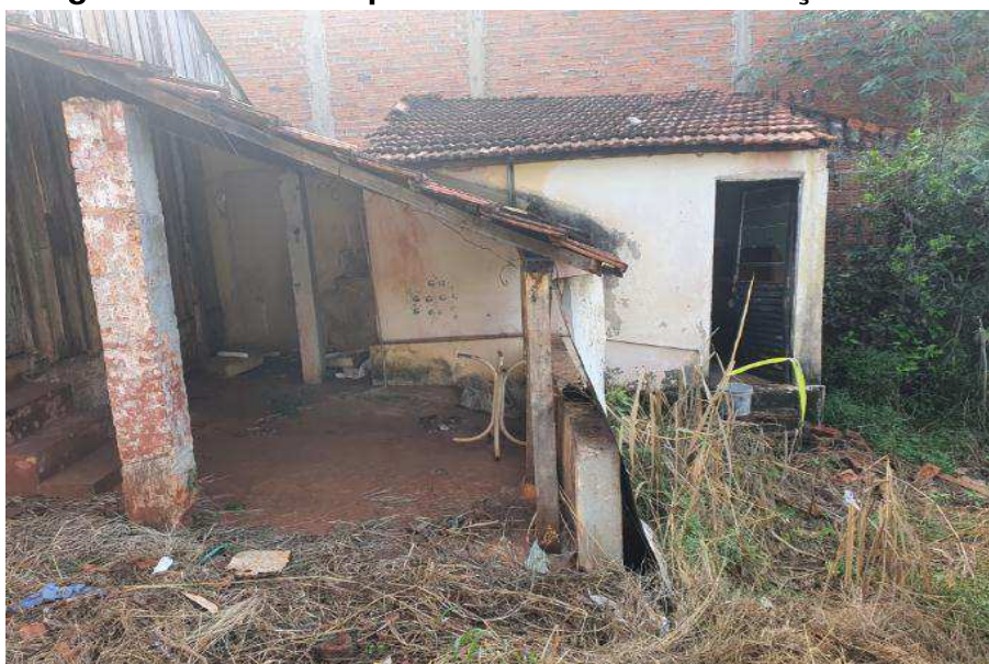
Imagem 20 – vista de parte de uma das construções do imóvel
