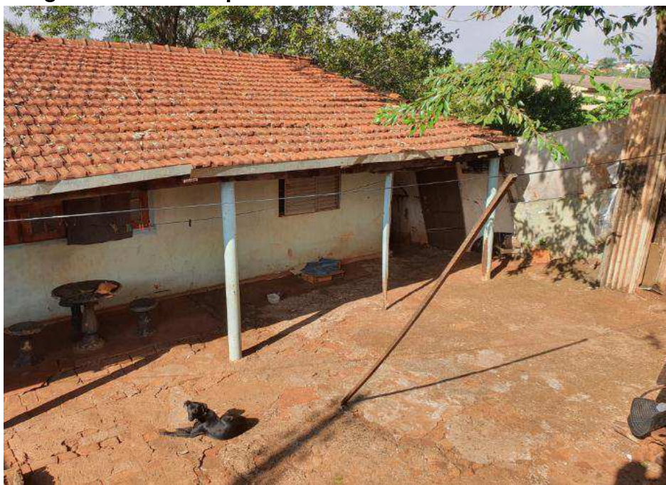
Imagem 7 – vista de parte do interior do imóvel
