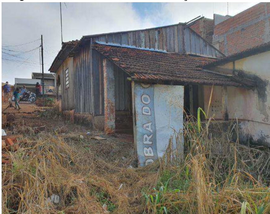
Imagem 19 – vista de uma das construções do imóvel
