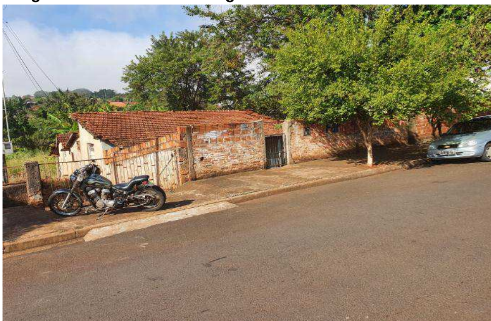
Imagem 2 – vista de outro ângulo da área frontal do imóvel
