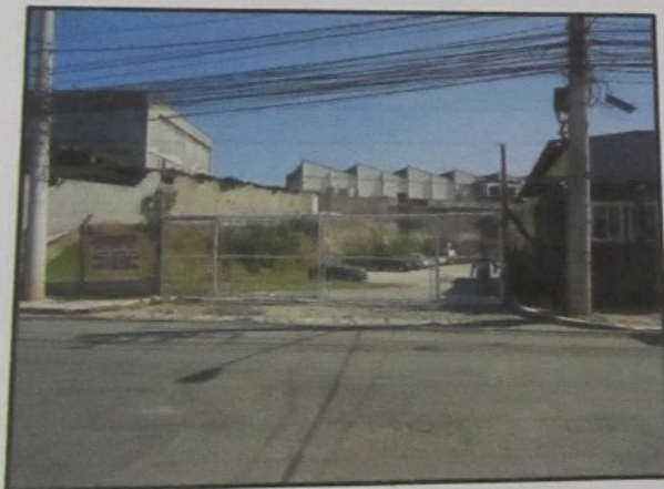
Vista geral da entrada do imóvel.
