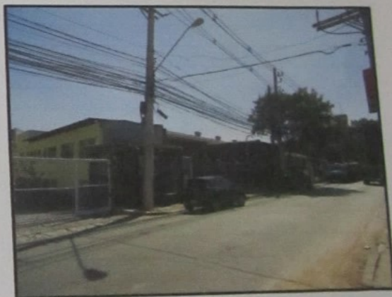
Vista parcial fachada junto a Rua João Ferreira de Camargo.
